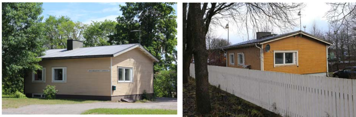
Kuva 17. Vasemmassa kuvassa Ratakatu 13:n ja oikealla kuvassa Ratakatu 19:n rakennus.
