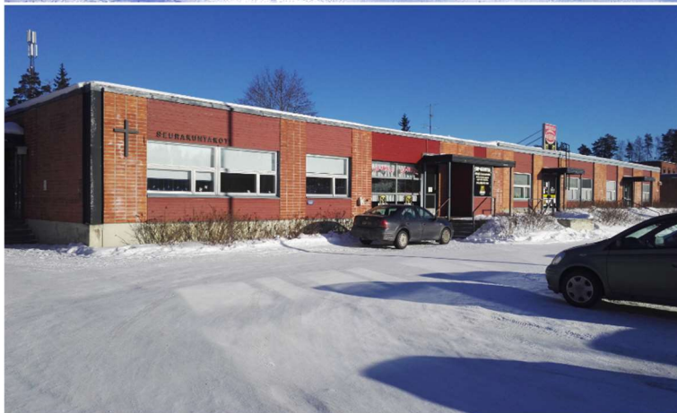
Kourulan monitoimitalo. Ylemmässä kuvassa talon pohjoispuoli (liikuntasali) ja alemmassa kuvassa eteläpuoli (kahvilaravintola ja seurakuntakoti).
