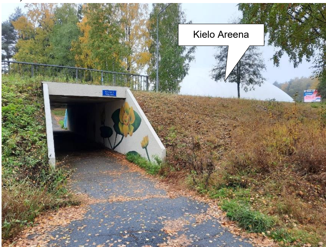
Kuva 16 Alikulkutunneli Skinnarilankadun ali kohti Kaartinkatua. Takana kuvassa näkyy Kielo Areena, lokakuu 2022
