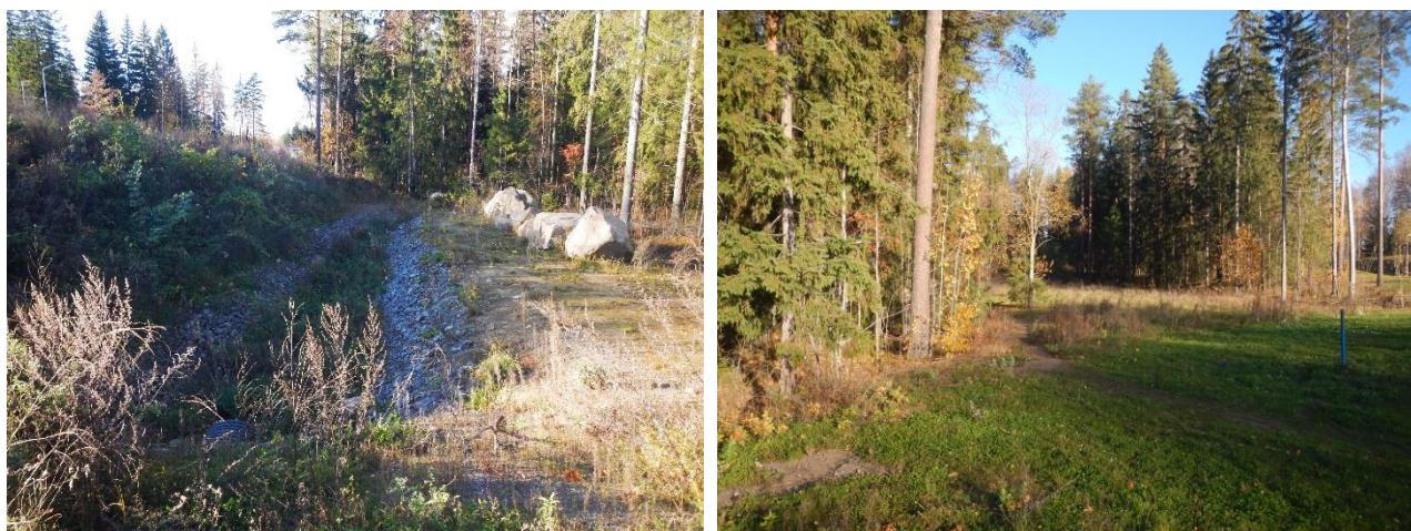
Kuva 32 Rapakivenpuistoa, lokakuu 2024. vasen: kaivettu oja, joka johtaa hulevesien viivytysaltaaseen. oikea: puuton kohta metsikössä osoittaa kohdan, johon vesijohto on kaape-loitu.
