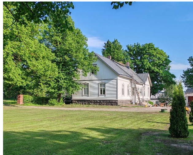
Kuva 22 Reijolan vanhan kantatilan päärakennus.
