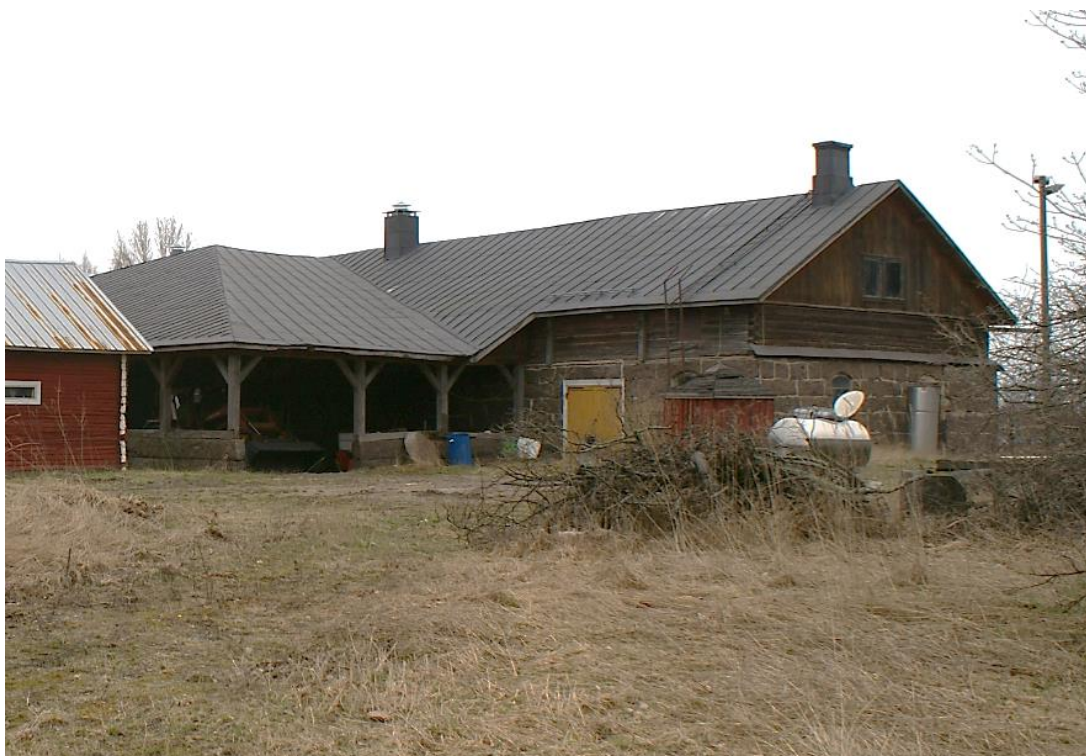
Kuva: Kivinavettaan liittyy aumakattoinen katos, jossa katon tukipatsaat tukeutuvat kivimuuriin tai kivipilareihin. Etelä-Karjalassa ja etenkin Länsi-Saimaan pitäjissä oli oma erityinen navettatyypinsä ns. patsasnavetta, jossa hirsiselle karjarakennukselle suojana ollut katos lepäsi omilla nurkkapatsailla tai korkealla kivijalalla. Luukkaan karjarakennuskompleksissa on samoja piirteitä. Karjasuojien rakentaminen kivistä yleistyi 1800-luvun lopulla, sementtitiilinavetat sitten 1900-luvun keskivaiheilla.
