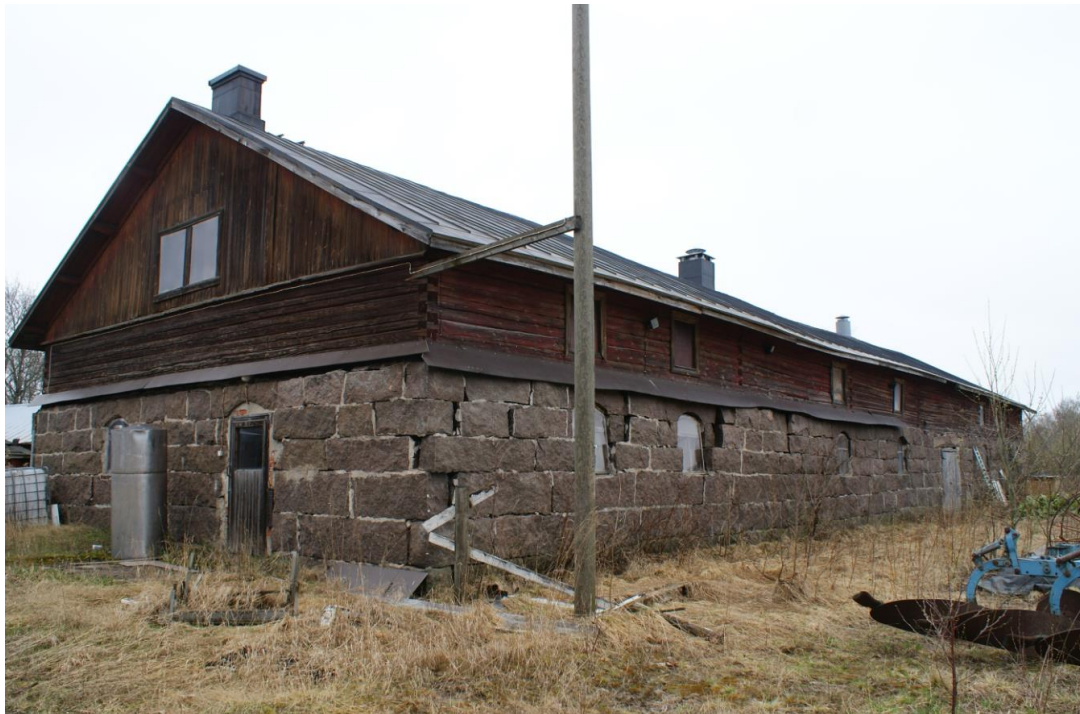
Kuva: Navetta on muurattu kivikvaadereista (saumaus), yläosa on hirsirunkoinen (lyhyet nurkat). Kiviosassa ikkunoiden ja ovien yläreuna on kaareva. Navetan lounaisseinällä, oven ja ikkunan väliseen kiveen on kaiverrettu navetan rakennuttajien nimet ja vuosiluvut (1900, 1906, toinen nimistä P. F. Luukas).
