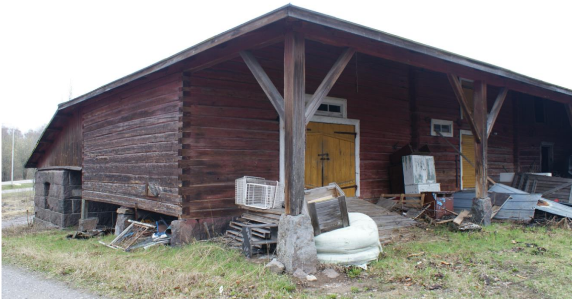
Kuva: Kivinavettaan nähten suorakulmassa sijaitsevan kookkaan hirsirakennuksen katto jatkuu katoksena. Takana näkyy pieni kivinen karjasuoja (1909).
