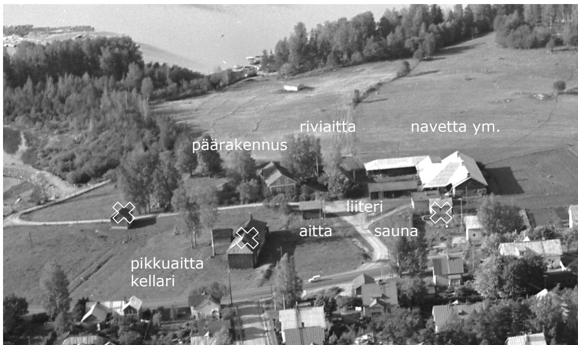
Kuva: Luukkaan talouskeskus vuonna 1964. Kuvaan ruksattu rakennukset, joita ei pihapiirissä enää ole. Myös inventoinnissa mainittu viljankuivaamo on purettu. Päärakennus ja aitat 1800-luvulta, navetan kiviosat 1900-luvun alkuvuosilta. / Pekka V. Virtanen, Etelä-Karjalan museo.
