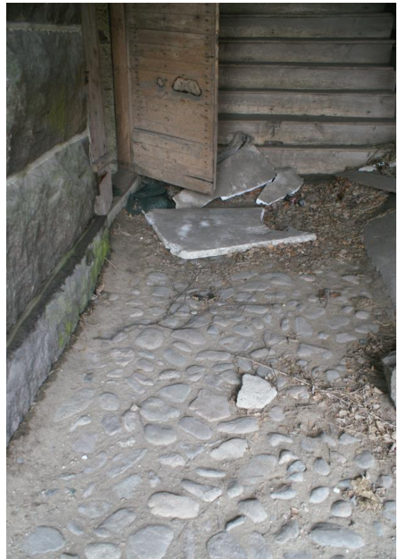
Kuva: Navetan hirsirunkoiseen siipeen liittyvä kivistä muurattu (saumattu) karjasuoja vuodelta 1909. Rakennusten välissä on portaikko ylhäälle rakennettuun käymälään. Välikön maalattia on kivetty luonnonkivillä.
