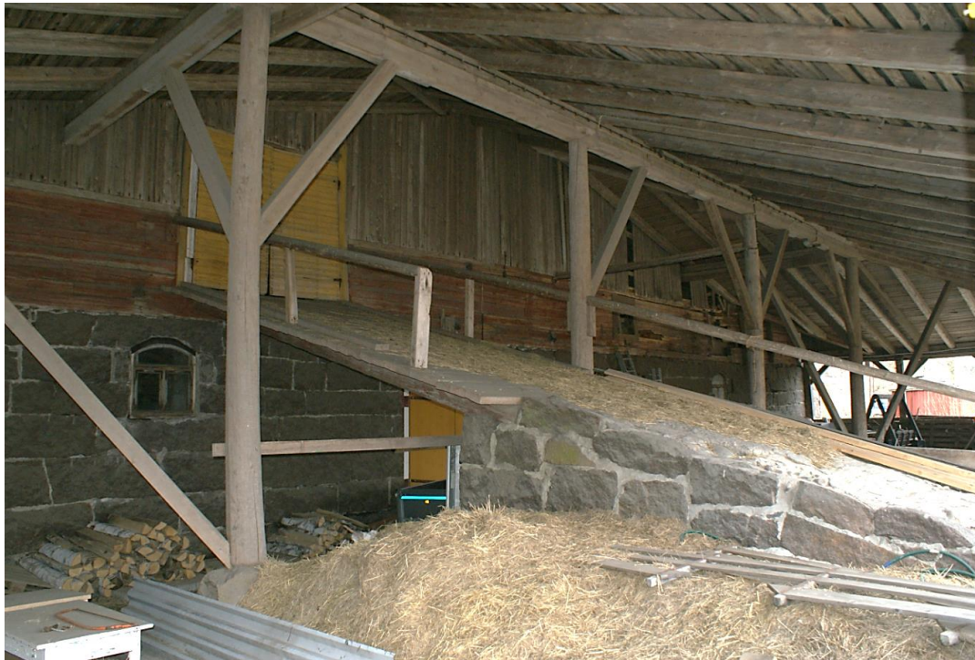
Kuva: Kivinavetan seinät ovat kivimuurausta, hirttä ja lautta. Kivistä tehty siltä navetan ylisille on pitkän katoksen suojassa. Katosta kannattelevat puupylväät on vahvistettu vitaposkin.
