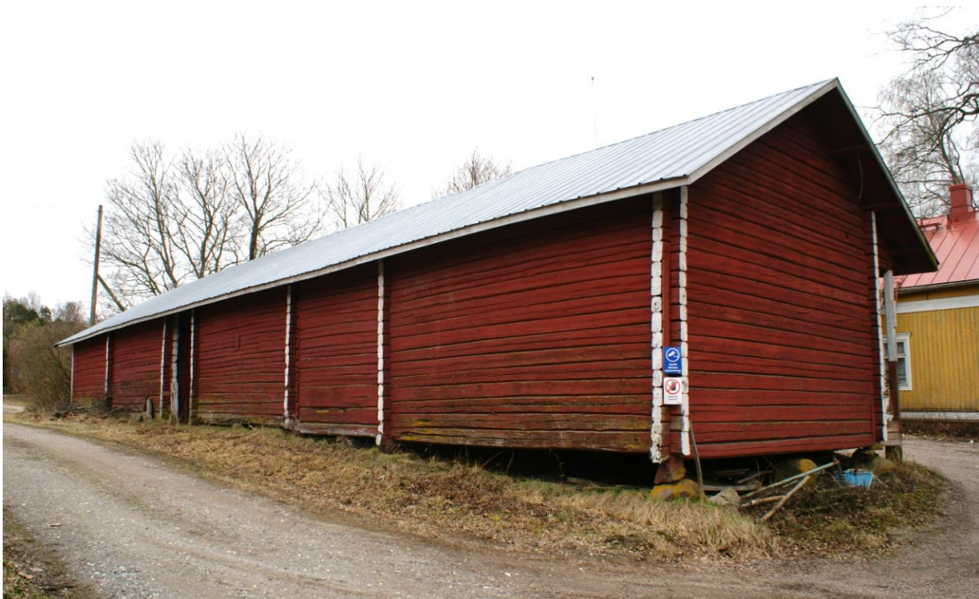
Kuva: Riviaittarakennuksessa on pariaitta ja hirsiväliköllä yhdistetyt kaksi omille nurkille salvottua aittaa.
