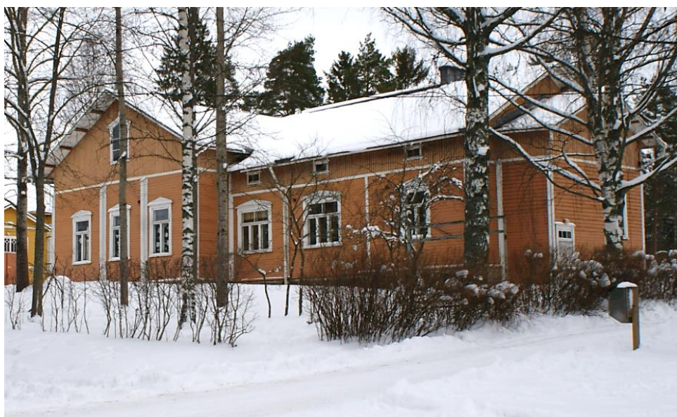
Kuva: Vanhin Mustolan kouluista on 1800-luvun lopun kertaustyylinen hirsirakennus, jossa sisäänkäynnit kaakkoispäädyn asuinhuoneistoon ja oppilaseteiseen ovat vierekkäin matalassa osassa ja kaksi luokkahuonetta vierekkäin rakennuksen luoteispäädyn vinkkelissä.
