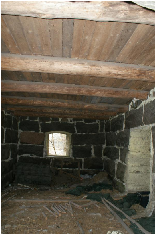
Kuva: Navetan hirsirunkoiseen siipeen liittyvä kivistä muurattu (saumattu) karjasuoja vuodelta 1909. Rakennusten välissä on portaikko ylhäälle rakennettuun käymälään. Välikön maalattia on kivetty luonnonkivillä.
