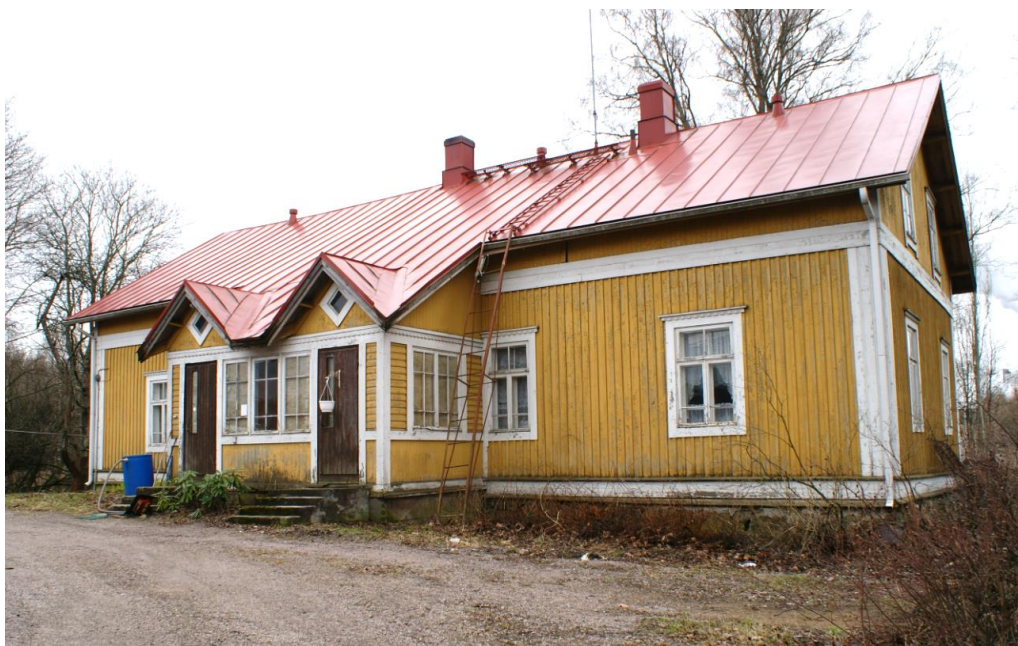
Kuva: Luukkaan tilan päärakennuksen kevyesti klassistiset tyylipiirteet ovat 1920-luvun uudistuksesta. Tämän jälkeen on taloon vaihdettu ulko-ovet ja vesikaton materiaali betonitiilestä peltiin.
