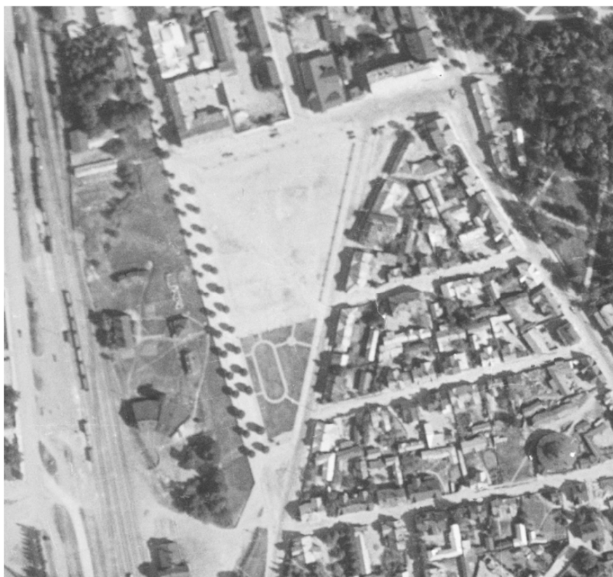
Kuva 17: Ilmakuvassa vuodelta 1939 erottuu kolmion mallinen aukio, jonka vasenta reunaa rajoittaa puurivistöjen reunustama Snellmaninkatu ja oikeaa reunaa viistosti kaupunkirakenteeseen sijoittuva Toikankatu, joka muistutti vuoden 1932 kuntaliitoksessa poistuneen Lappeenrannan kaupungin ja Lappeen pitäjän välisen rajan sijainnista. Oikeassa reunassa erottuu Lappeen pitäjän puolelle 1900-luvun alkupuolella rakentunut esikaupunkialue (Maanmittauslaitos)
