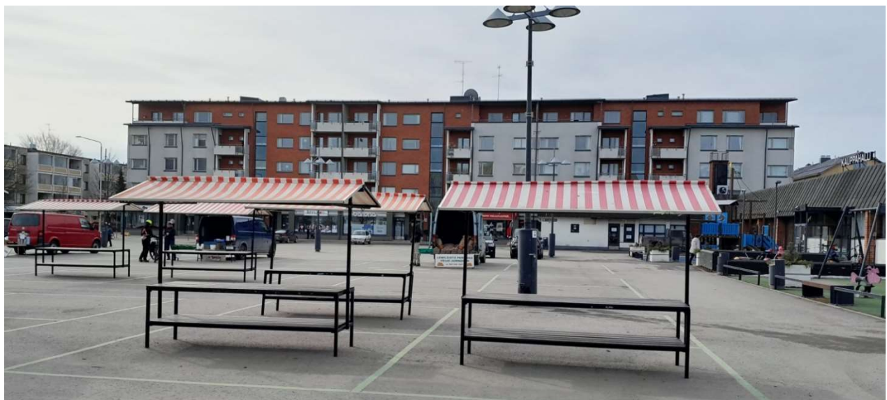
Kuva 32: Lappeenrannan Kauppatori ja taustalla Kiinteistö Oy Kievarinkatu 1 ja oikealla kauppahalli. (Lappeenrannan kaupunkisuunnittelu 2023)
