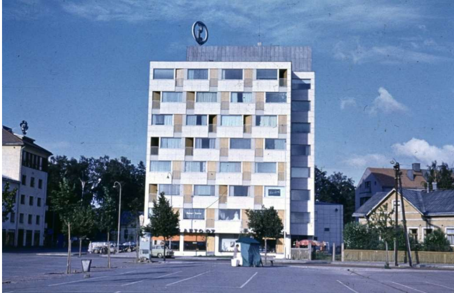
Kuva 23: Kuvan keskellä Säästöpankin 8-kerroksinen asuin- ja lii-kerakennus, vasemmalla Oksasenkatu ja Karjalankulman 5-kerroksinen liike- ja toimistorakennus, oikealla ns. torikorttelin länsireunalla oleva puurakenteinen asuinrakennus. (Kivinen Olli 1960-69, Lpr museot)
