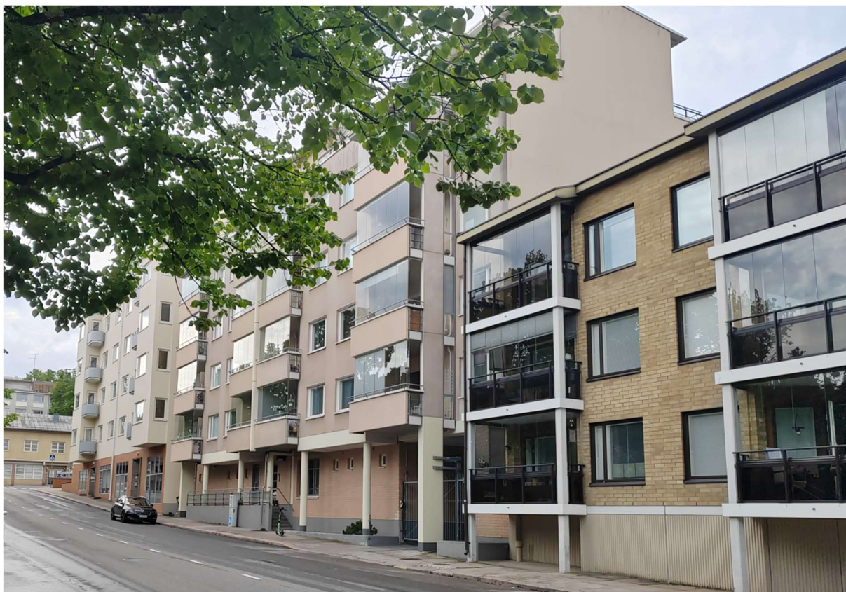
Kuva 32 Kipparinkadun kerrostaloja kuvattuna keskustan suuntaan.
