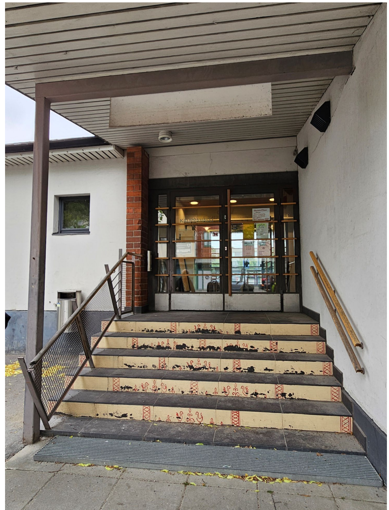
Kuva 88. Sisäänkäynti Snellmaninkadun puolelta. Ulko-ovet ja kaiteet on uusittu vuonna 2002.
