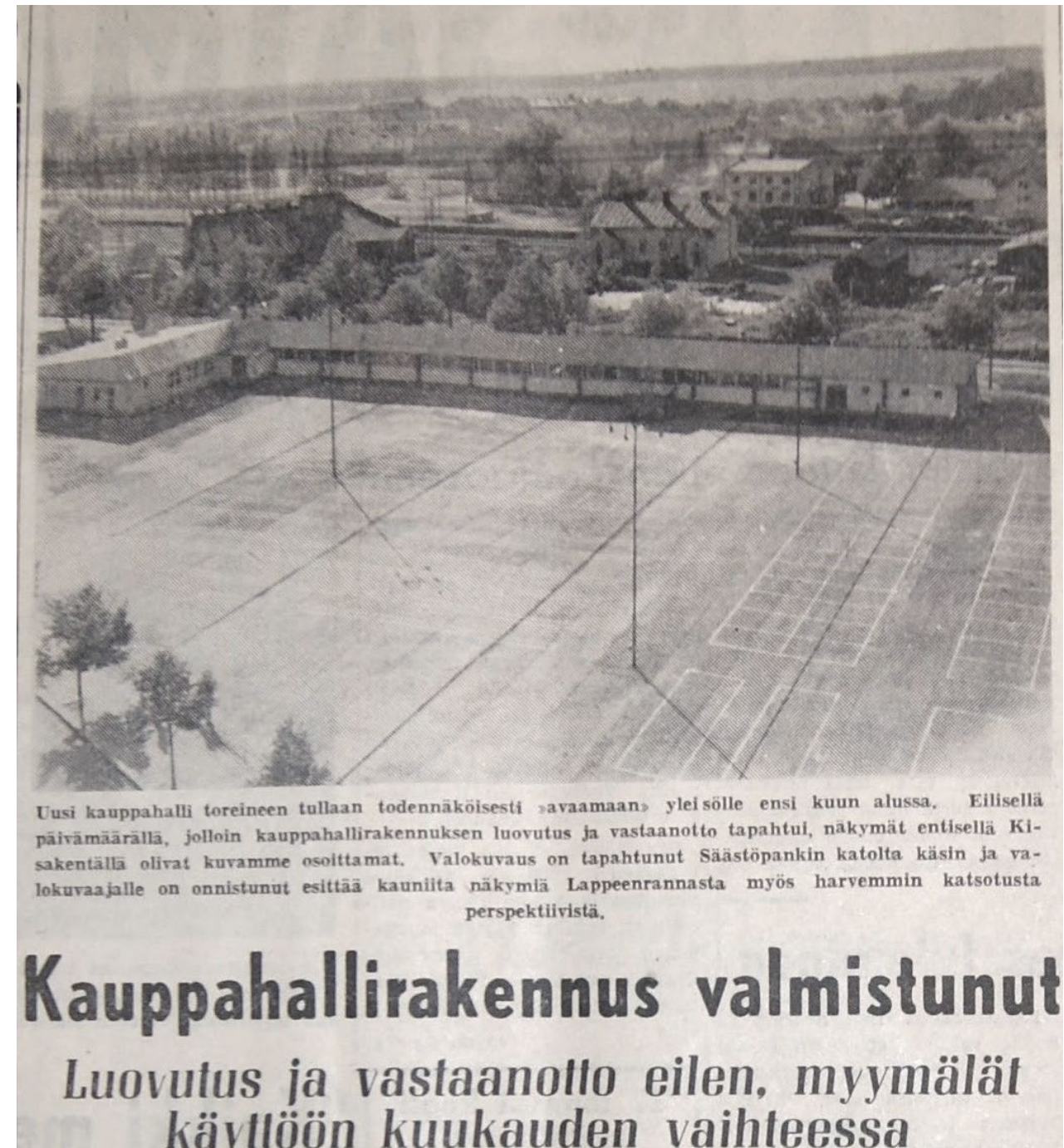
Kuva 46. Etelä-Saimaan julkaisi uutisen kauppahallin valmistumisesta 19.9.1956.
