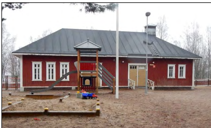
Kuva 4. Päiväkodin aumakattoinen uudisrakennus.
