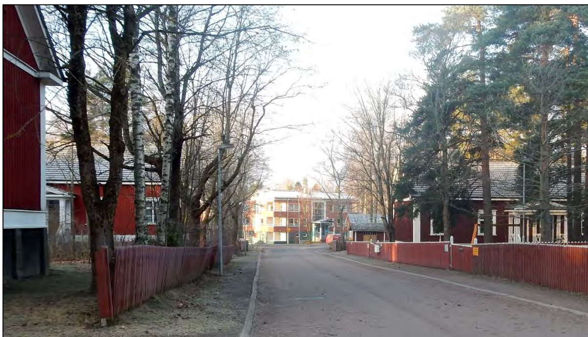
Kuva 12. Näkymä Telakanmäenkadulta suunnittelualueen länsipuolen pienkerrostaloalueelle.
