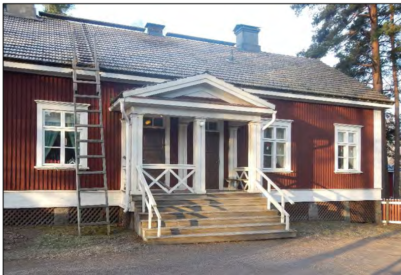
Kuva 6. Avokuisti päätykolmioineen. Sisäpihan puoleisilla kuisteilla ei ole kaidetta ulko-oven edessä.
