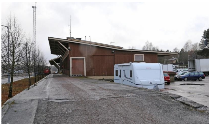
Tavarasuoja, lastauslaituri ja toimistorakennus koillisesta 2017.
