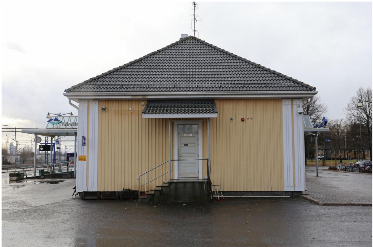
Asemarakennus koillisesta vuonna 2017. Päädyn alkuperäinen pariovi ja tavaraluiska on korvattu portaikolla ja kapeammalla ovella.
