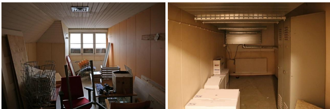
Entistä toimistotilaa ja varasto rakennuksen ullakon lounaispäädyssä 2017.
