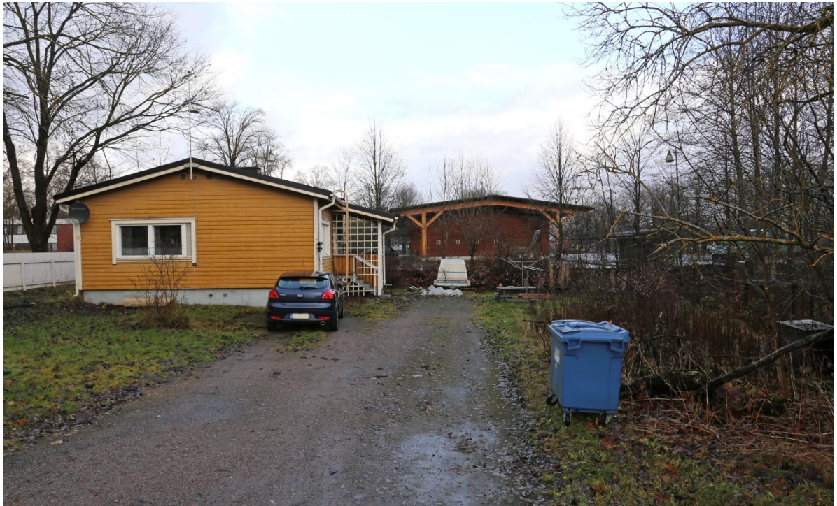
Ratakatu 19 asuinrakennus lounaan suunnasta vuonna 2017.
