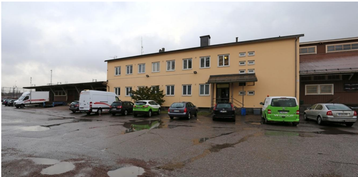
Toimistorakennus luoteesta 2017. Rakennus ja tavarasuojat ovat rungoltaan, kattomuodoiltaan ja aukotukseltaan lähes alkuperäiset. Oikeanpuoleinen 1930-luvulla rakennettu tavarasuojaja on korotettu 1960-luvun alussa. Toimisto-osan sisäänkäynnin katos on alkuperäistä suunnitelmaa leveämpi ja varasto-osien oviaukkoja on alkuperäisestä hieman levennetty.
