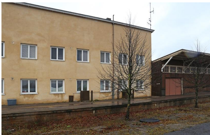
Toimistorakennus, lastauslaituri ja tavarasuoja radan puolelta 2017. Alkuperäinen toisen kerroksen parveke on poistettu.
