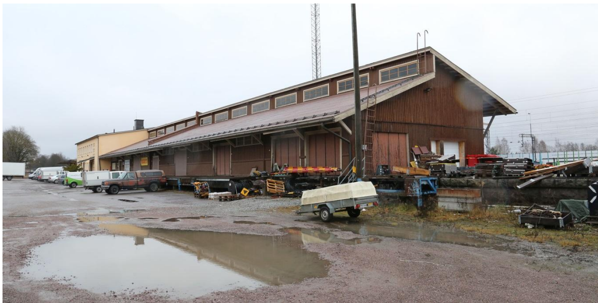
Tavarasuojan vanhin osa ja toimistorakennus lännestä 2017.
