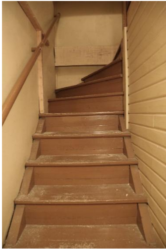
Ullakon portaikko vuonna 2017 on alkuperäisessä asussaan.
