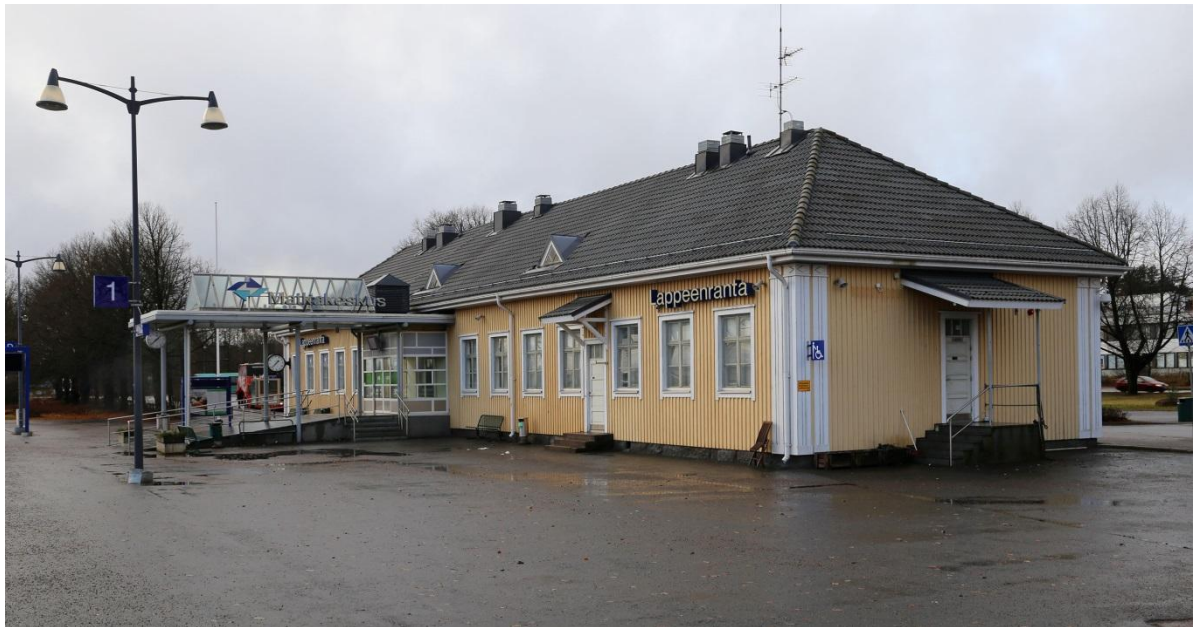
Asemarakennus idästä radan suunnasta vuonna 2017.
