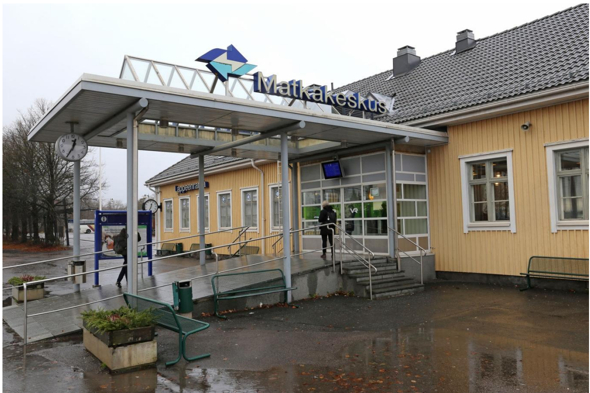
Asemarakennuksen uusi katos ja tuulikaappi radan puolelta vuonna 2017.
