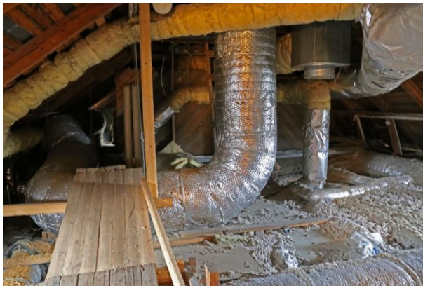
Ullakkotilaa rakennuksen keskiosassa 2017.
