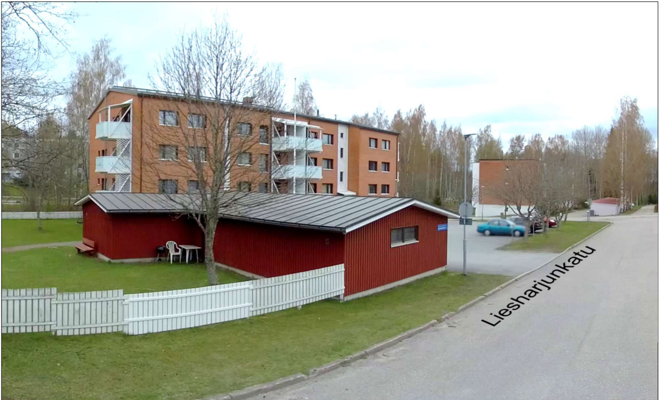
Kuva 6 Liesharjuntatu 1 asuinkerrostalo ja varastorakennus Liesharjuntadulta päin kuvattuna (LPR katukuvat, 2025)
