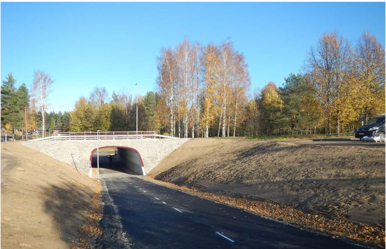
Kuva 19 Kiviniemenraitti, joka alittaa Skinnarilankadun alikulkutunnelia pitkin, lokakuu 2024
