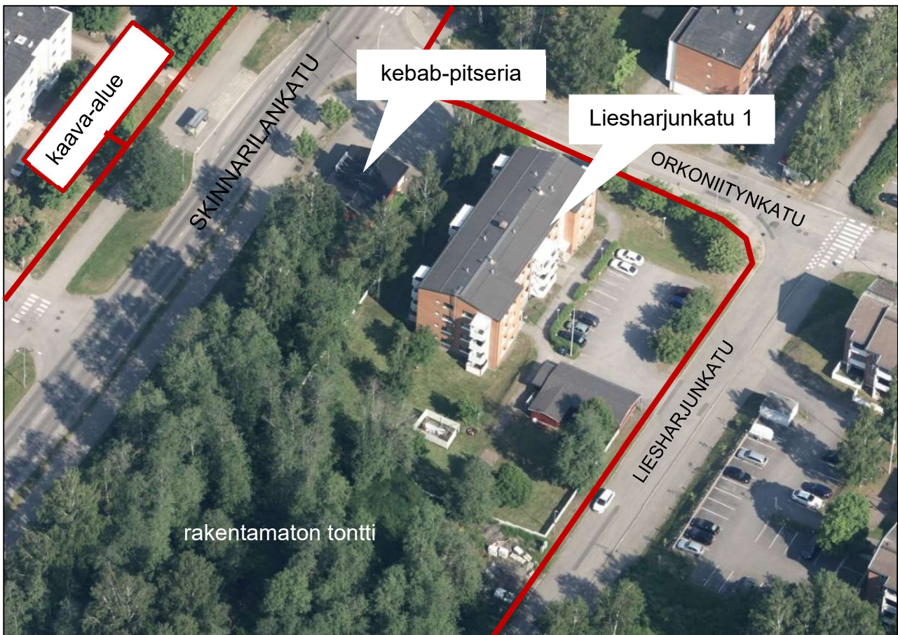
Kuva 5 Viistoilmakuva kaava-alueen rakennuksista (Blom, 2023)
