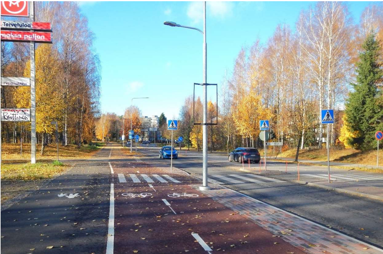
Kuva 18 Skinnarilankatu kuvattuna pohjoiseen. Kuvassa vasemmalle kääntyy ajoyhteys Sammonlahden aluekeskuksen pysäköintialueelle, lokakuu 2024
