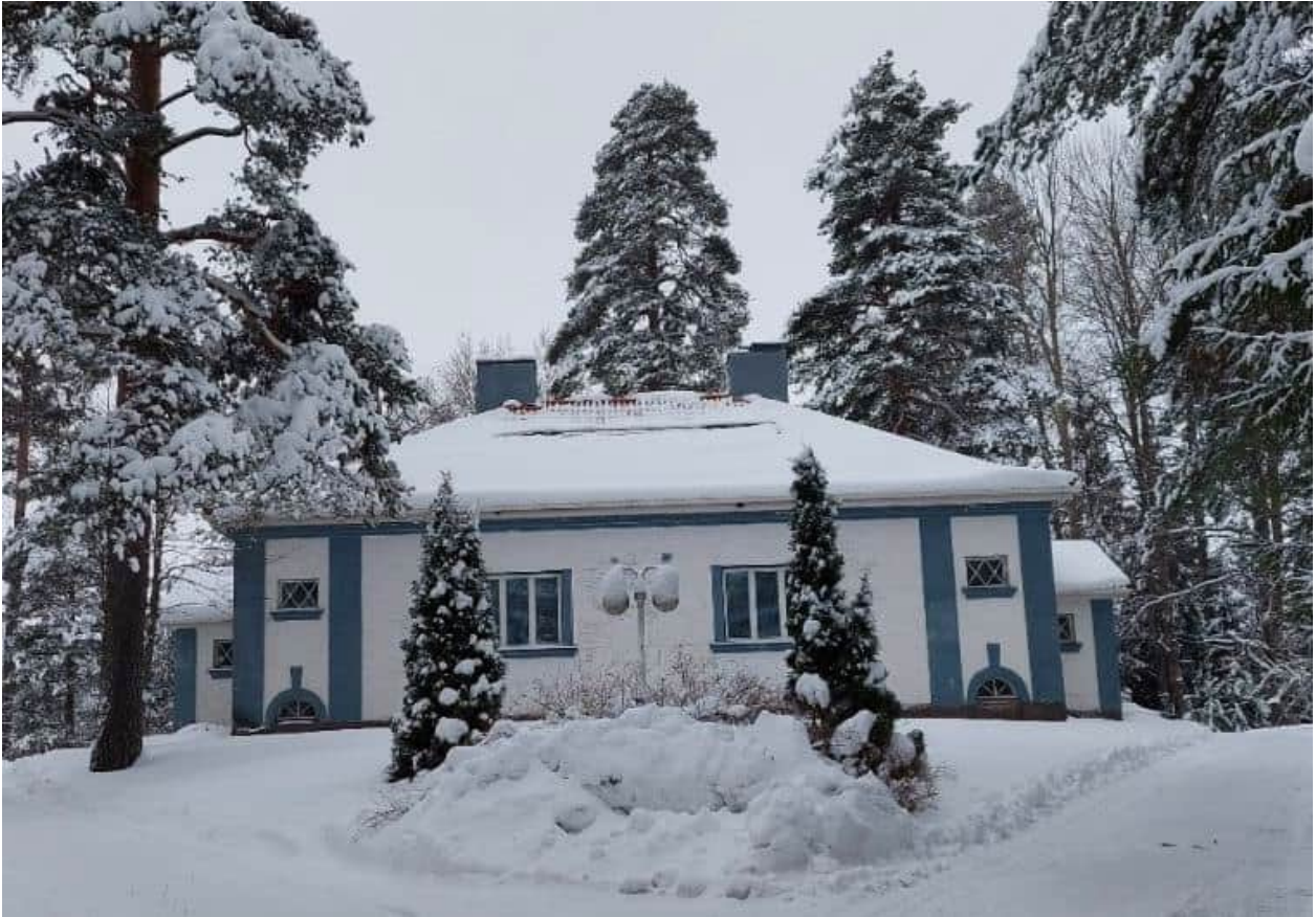
Kuva 28. Kivisaaren avolaitoksen esimiehen asuinrakennus
