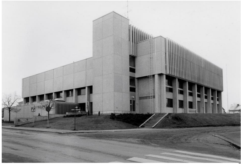
Kuva 12: Pääkirjaston julkisivut Valtakadulle 1970-luvun lopulla, jossa kerroksellinen strukturalismi on vahvasti osana arkkitehtuuria. (Aarne Mikonsaari 1974-1979, Lpr museot)
