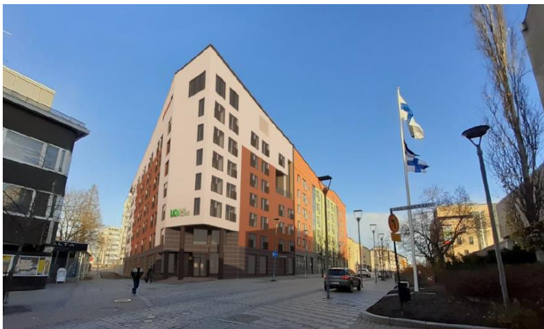
Kuva 18: Näkymä Anni Swanin ja Valtakadun risteyksestä katsottuna kohti vanhan teatterin korttelia, jonka länsikulmalle on sijoitettu asemakaavan muutoksen mahdollistama osin kahdeksankerroksinen opiskelijatalo, oikealla palvelukeskussäätiön senioritalo ja Valtakadun oikealla puolella sijaitsee pääkirjasto. (25.2.2021 Arkkitehdit Soini & Horto Oy).
