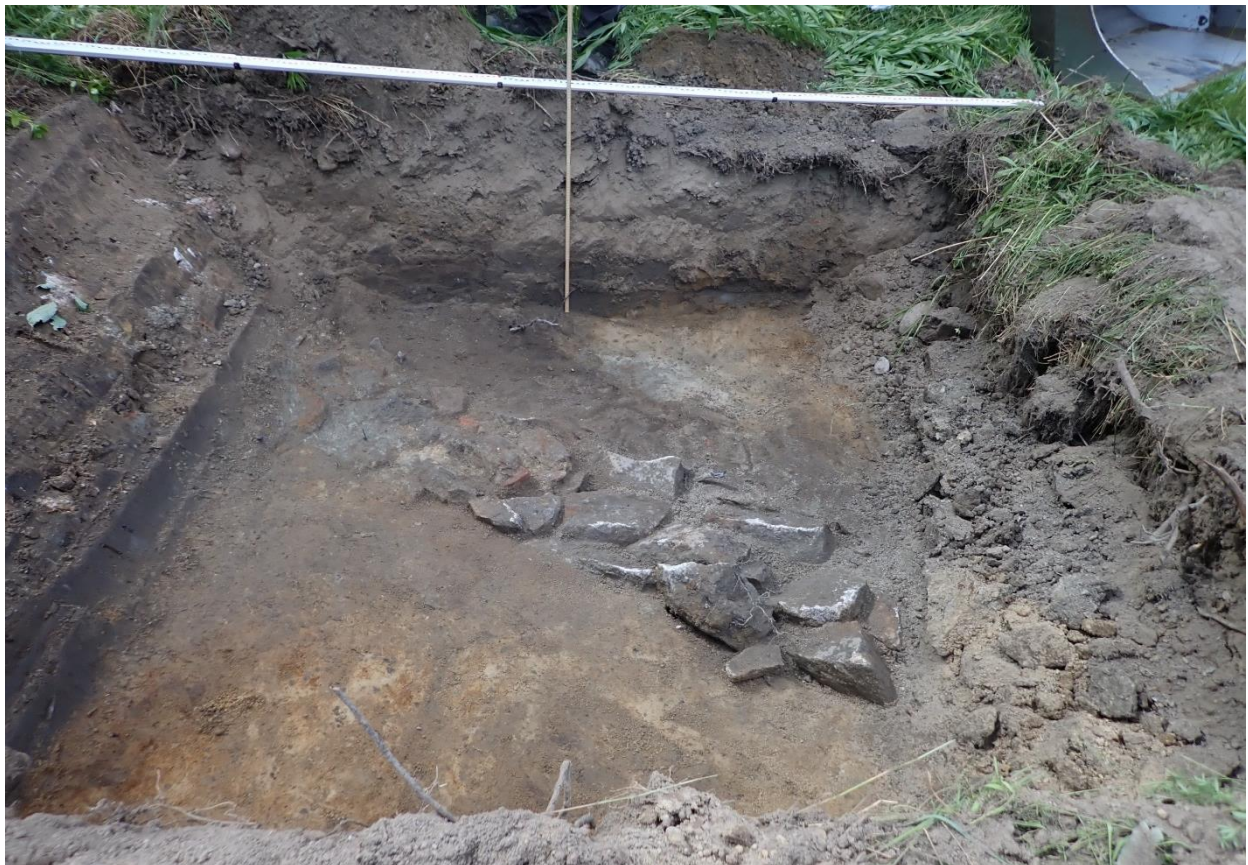
Kuva 14. Koekuopassa 3 havaittu 1900-luvun rakennuksen lohkokiviperustus. Pohjoisesta.
