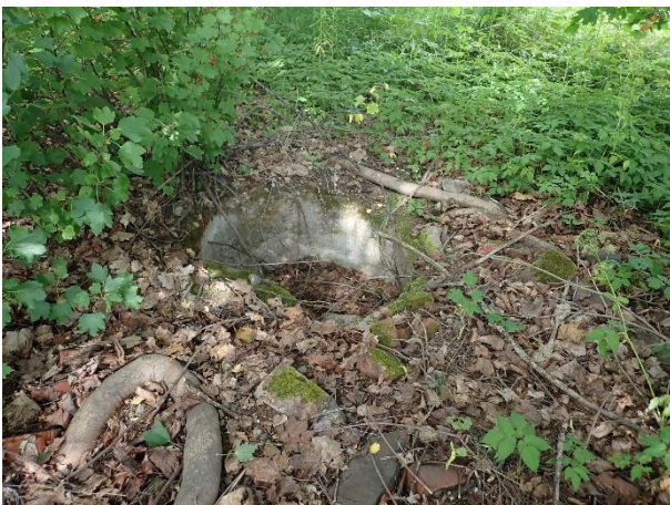
Kuva 35. Betoninen kaivo ja sen ympärillä rautaromua, betonia ja tiiltä. Lounaasta.
