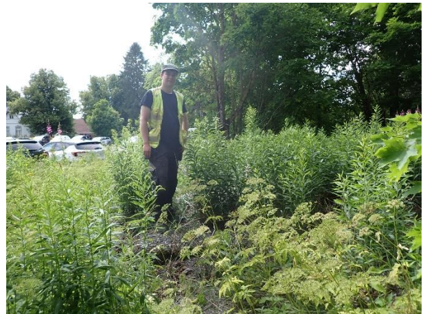
Kuva 34. Maaston peitteisyyden vuoksi huonosti erottuva rakennuksen betoniperustus. Idästä.
