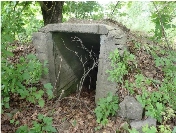
Kuva 33. Maakellarin betoninen sisäänkäynti. Lounaasta.
