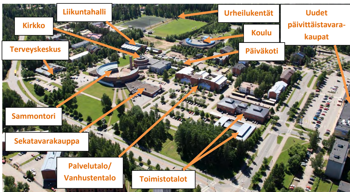
Kuva 35 Sammonlahden julkiset ja palvelurakennukset viistoilmakuvassa. (Lappeenrannan kaupunki)
