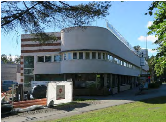
Kuva 47. Peter Bieberin ja Ritva Luodon suunnittelemissa, vuonna 1988 valmistuneessa Utrantien liike- ja toimistorakennuksessa on jo hyvin selkeät postmodernistiset tyylipiirteet. (Kuva: https://docplayer.fi/110782639-Pohjois-karjalan-arkkitehtuuria-osa-2.html )
