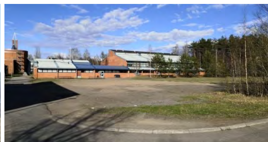
Kuva 197. Liikuntahalli nähtynä kaakon puolelta. Hallin edessä on hiekkakenttä, joka tekee alueesta viimeistelemättömän oloisen. Vasemmalla näkyy Sammonlahden kirkkoa.
