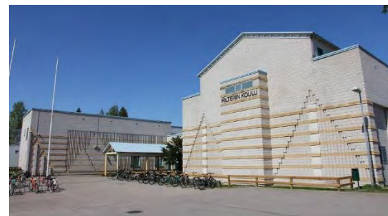
Kuva 148. Kilterin koulu Vantaalla on arkkitehtuuriltaan postmodernistinen. Koulu on valmistunut vuonna 1987. Julkisivut ovat vaaleaa tiiltä, jota on jaettu osiin erilaisin elementin. Katto ja muut peltiosat ovat vaaleansiniset. ( https://upload.wikimedia.org )
