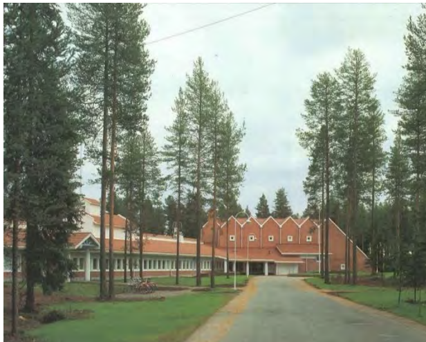
Kuva 112. Leivolankoulu ja päiväkoti on valmistunut vuonna 1986 ja sen on suunnitellut "Oulun koulun" postmodernismin päätekijöihin kuulunut arkkitehti Heikki Tasanen. Rakennus on Sammonlahden keskusrakennusten tyyliin punatiilisiä ja niissä on selkeä postmodernistinen ote. (Kuvat: https://finnisharchitecture.fi/ / Ilpo Okkonen / MFA)
