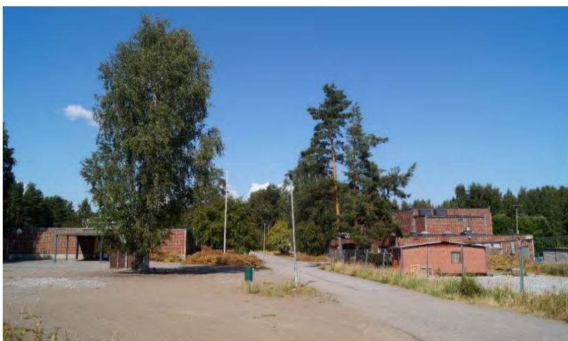
Kuva 56. Vasemmassa laidassa Skinnarilan koulu, oikeassa parakin takana liikuntahalli, jossa on myös puukäsityöluokka. Keskellä Skinnarilan palvelurakennusten välissä kulkeva Ostosraitti.
