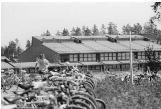
Kuva 192. Sammonlahden liikuntahalli kuvattuna 1990-luvulla. Saattaa olla, että halli on vielä viimeistelytyötä vaille valmis, sillä katolla olevia kattolapteen osiin jakavia korotuksia ei vielä ole tehty. (Kuva: Lappeenrannan museot / Finna.fi)
