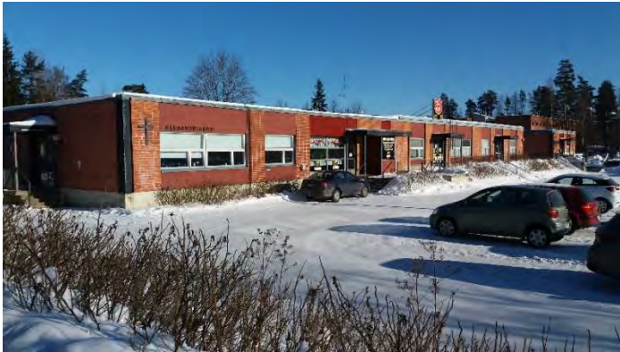
Kuva 71. Kourulan rakennukset ovat elementtirakenteisia, punatiililaatoin verhottuja. Ikkuna-aukotusten kohdalla julkisivu on punaista puuta. Maaston tasoerojen vuoksi alueella on joitain mielenkiintoisia siltamaisia kulkuyhteyksiä, mutta toisaalta myös puhtaaksi valettua betonipintaa varsin paljon.
