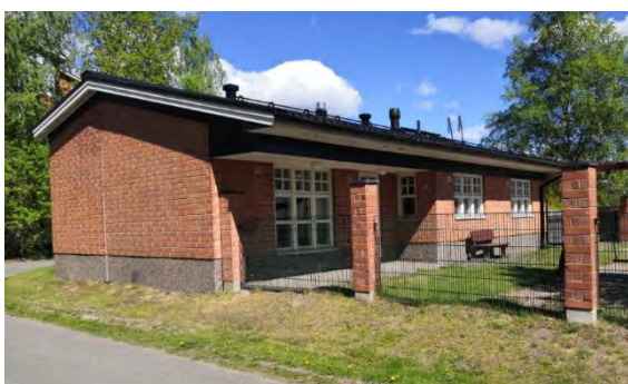
Kuva 120. Talonmiehen asuntoon on tehty sisätilamuutoksia vuonna 1996 ja lisäksi katto on uusittu ja yläpohja lisälämmöneristetty vuonna 2009.
