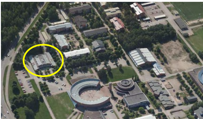
Kuva 219. Viistoilmakuva alueesta. Vasemmalla Skinnarilankatu, terveyskeskus ja asuinalueita. Keskellä C-mallinen Sammontori, jonka vieressä kirkko, päiväkoti ja oikeassa laidassa koulu. (Blom viistoilmakuva)
