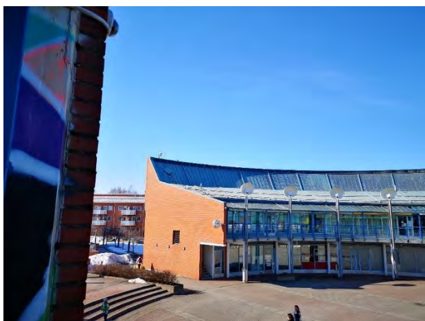
Kuva 105. Sammontorin rakennusta ja toritilaa rakennuksen toisesta kerroksesta, jossa on katettu ulkokäytävä.
