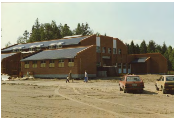
Kuva 220. Vuonna 1986 valmistunut Sammonlahden terveysasema rakenteilla. Rakennuksessa on mielenkiintoiset ikkunat, jotka ikään kuin jatkuvat julkisivusta räystäslinjan kautta kattopintaan. (Lappeenrannan museot / Finna.fi)
