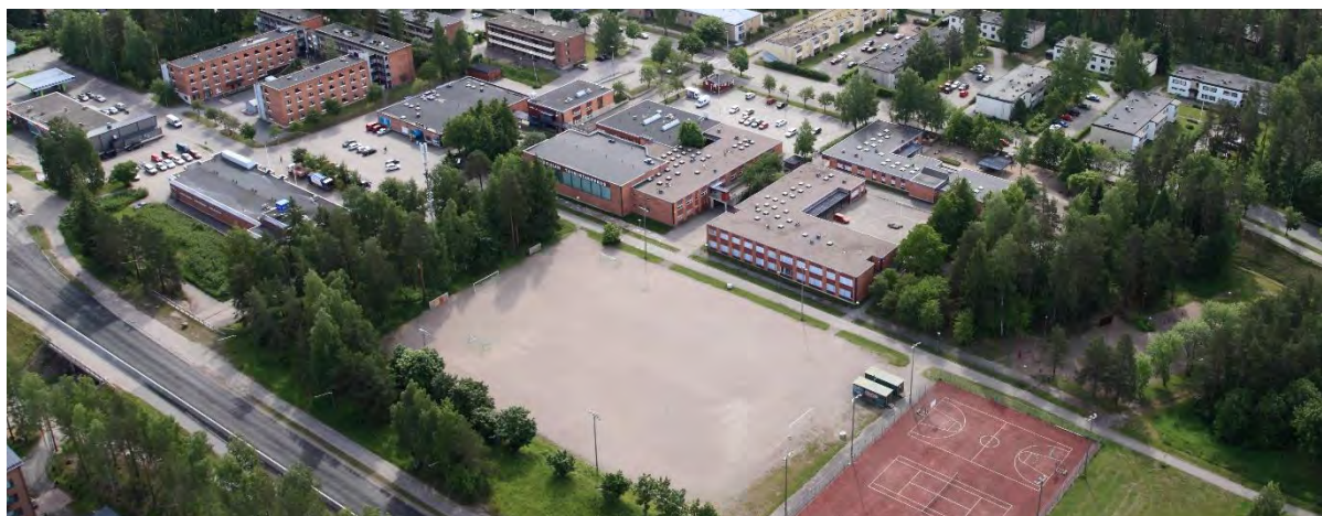
Kuva 74. Kourulan aluekeskus viistoilmakuvassa ennen päiväkodin purkamista ja uuden rakentamista.
