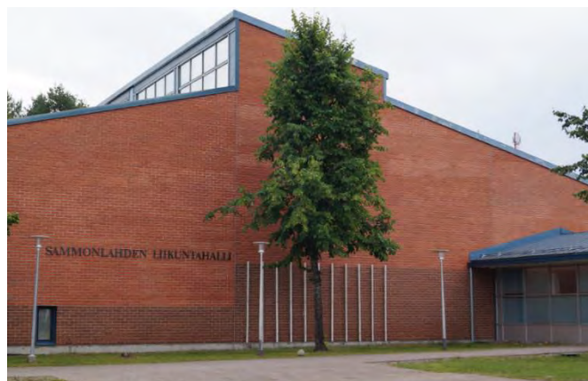
Kuva 198 Liikuntahallin luoteispääty, oikealla sisäänkäynti. Sisäänkäynnin luona rakennuksen tiiliseinässä on valkoisia koristerimoituksia ja tiilivärin vaihtelua punatiilen ja tummanpunaisen kesken.
