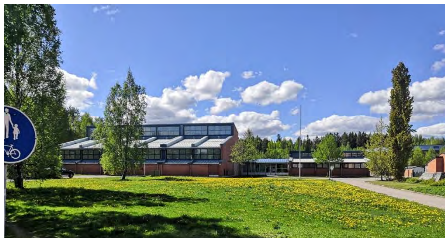
Kuva 194. Liikuntahalli nähtynä koillisesta. Oikealla päiväkodin pääty.
