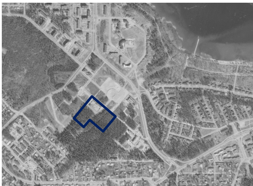
Kuva 10 Vuoden 1987 ilmakuvassa näkyy päiväkotirakennus sekä ilmeisesti Sammontorin pohjalaatta tai perustukset. Koulun ja liikuntahallin alue on metsäistä maata. Aluekeskuksen kaakkoispuolelle on rakenteilla asumista. (Maanmittauslaitos)
