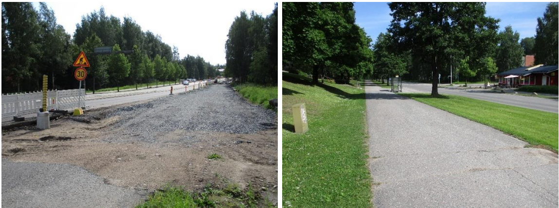
Kuvat 7 ja 8. Skinnarilankadun työmaa Sammonlahden keskuksen kohdalla ja kadun ja kevyen liikenteen väylän aluetta sen pohjoispuolella.
