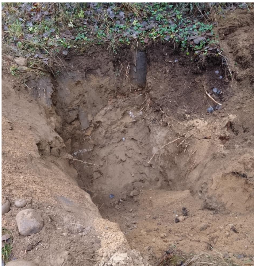
Kuva 4. KK9 tehtiin alueelle, jossa oli orgaanista ainesta sisältävä täyttömaakerros. Hiekkainen perusmaa alkoi noin 2 metrin syvyydeltä.
