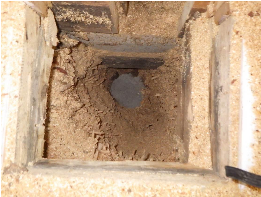
Kuva 17. Rakenneavaus VP1. Pohjalla puru/kutteri on hieman tummempaa.
