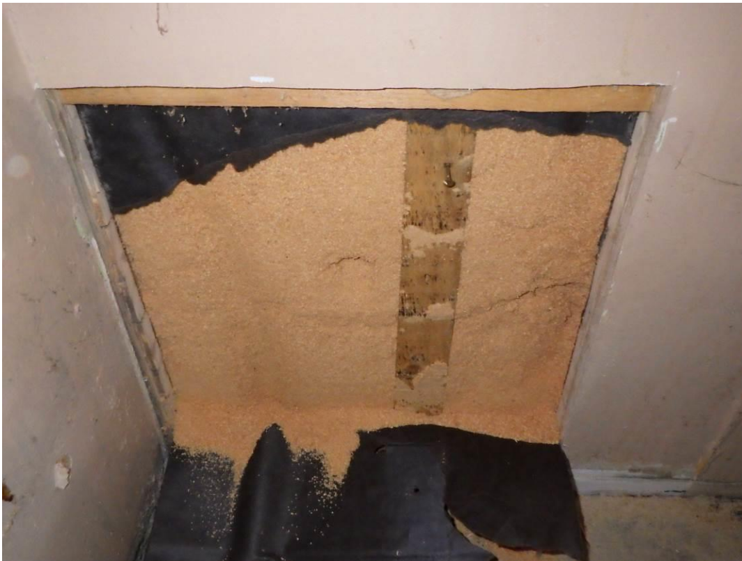
Kuva 13. Rakenneavaus US2. Purussa ei tummenemista.
