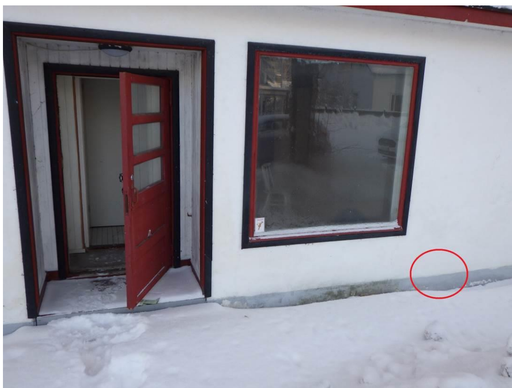
Kuva 9. Rakenneavaus US1 kohta ulkoapäin.
