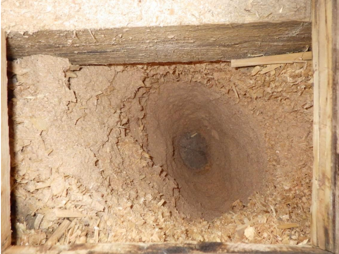
Kuva 18. Rakenneavaus VP2. Purun/kutterin väri ei havaittavasti muuttunut.
