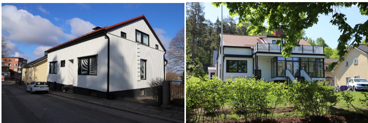
Kuva 16 Neulasepänkatu 6, vasemmanpuoleinen kuva on kuvattu kadulta ja oikeanpuoleinen rannan puolelta.
