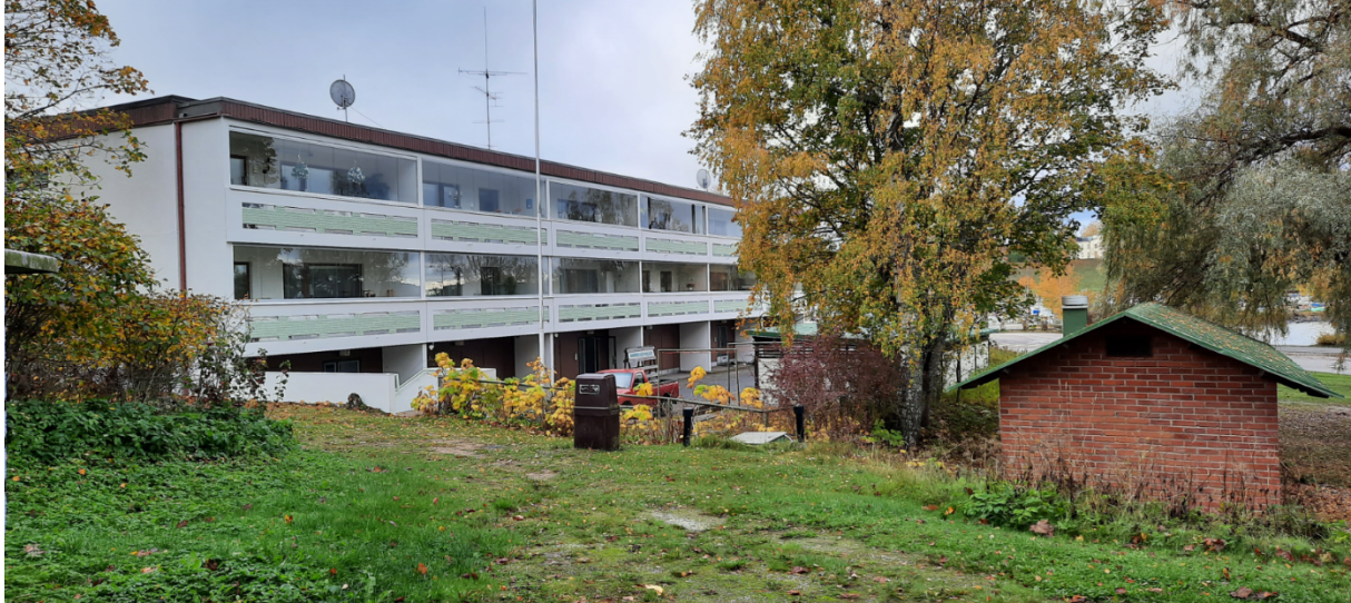
Kuva 25 Asuinkerrostalo kuvattuna sen eteläpuolelta puistosta. Kuvassa näkyy myös punatiilinen pumppaamorakennus.
