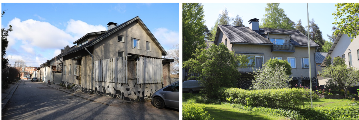
Kuva 23 Neulasepänkatu 12, vasemmanpuoleinen kuva on kuvattu kadulta ja oikeanpuoleinen rannan puolelta.
