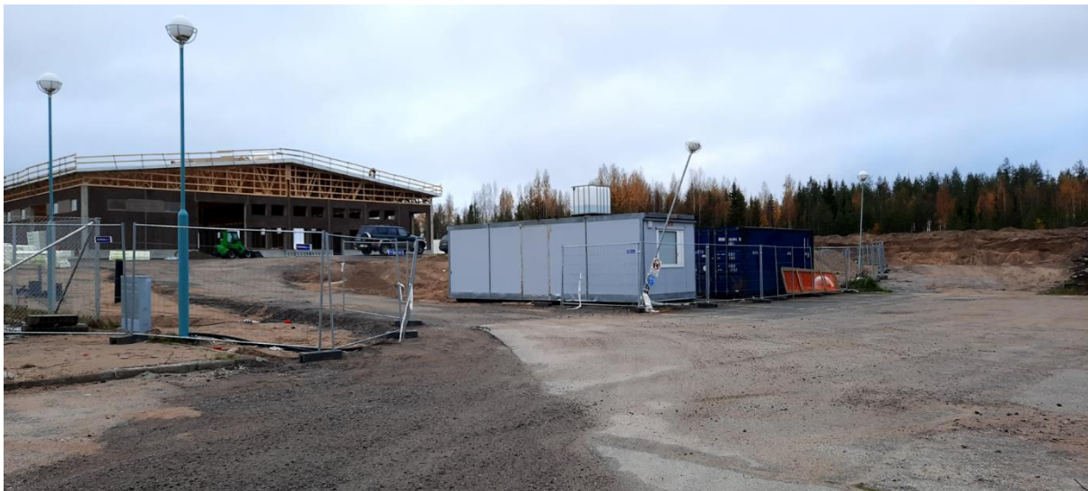
Kuva 10 Agromaster Oy:n rakenteilla oleva tuotantorakennus. Kuva syksyiltä 2020.
