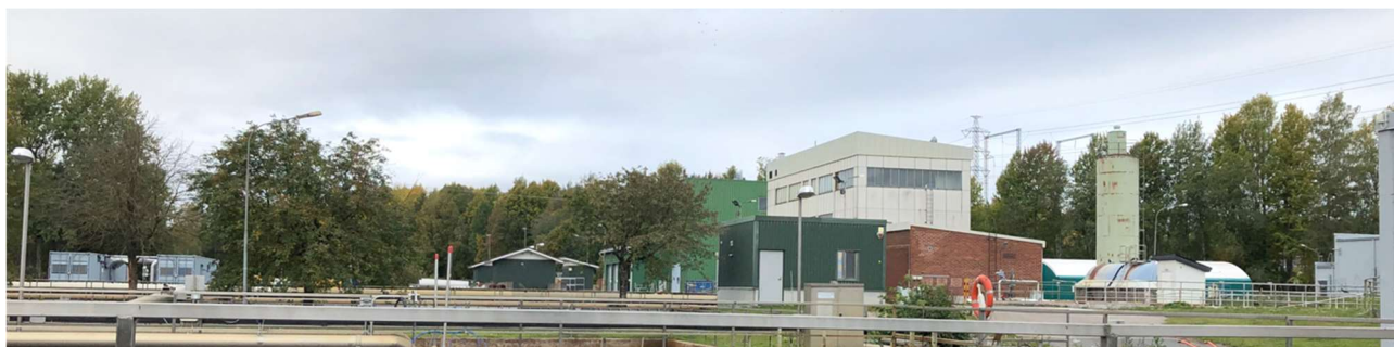
Kuva 4. Vanhinta rakennuskantaa jätevedenpuhdistamolla.
