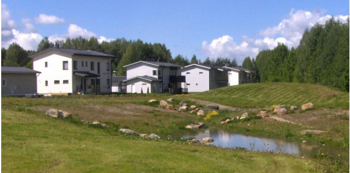
Kuva 6. Esimerkki hulevesien viiytyspainanteesta. (© Ramboll)
