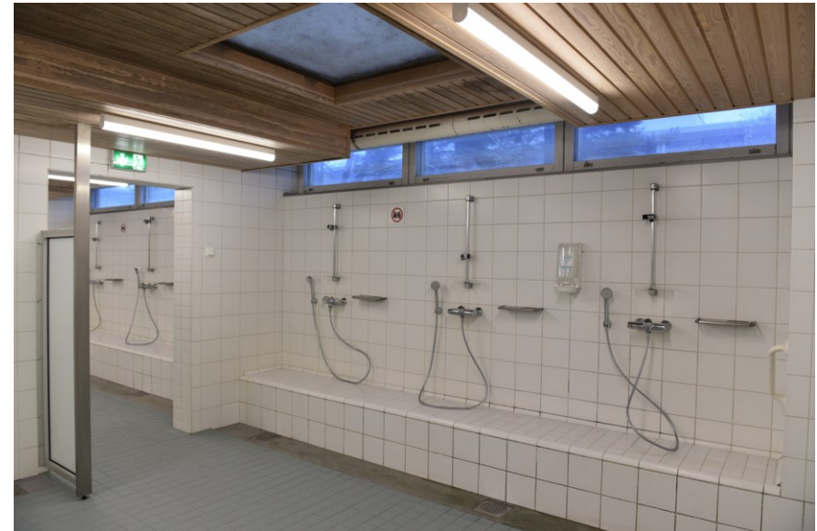
Kuva: Miesten pesuhuone, Kaakeloitu seinäpenkki suihkujen kohdalla. Pinnat uusittu, samoin alakatto. Alkuperäiset ikkunat vaaleiksi maalattuna (sisäpuiteessa lämpöelementti).
