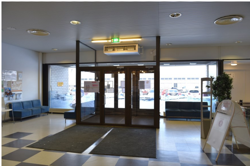
Kuva: Eteishalli ja pääsisäänkäynti, joka on siirretty lasiseinän oikeasta laidasta keskelle.
