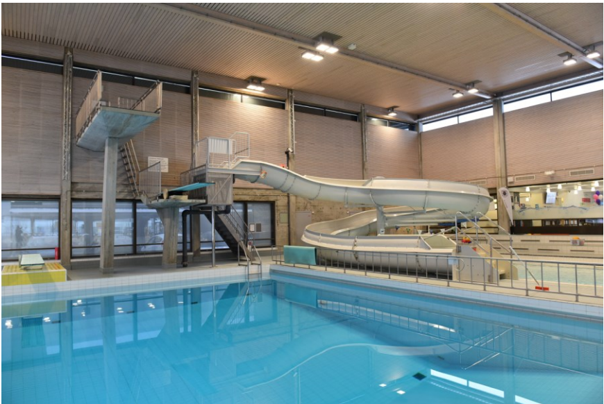
Kuva: 2000-luvun alussa rakennettu vesiliukumäki. Alkuperäisten teräsconisten hyppytelineiden kaiteet on uusittu.
