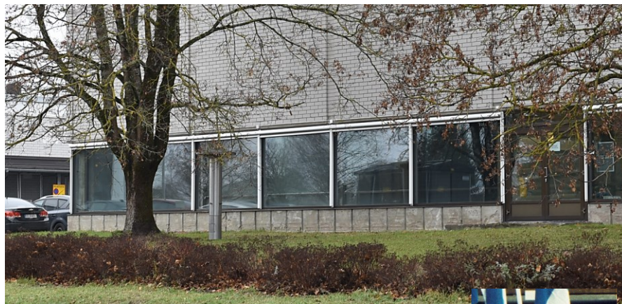
Kuva: Allashallin isot ikkunat, joiden alkuperäisen tumman kehyksen päälle on asennettu valkoisella rungolla olevat kaihtimet.
