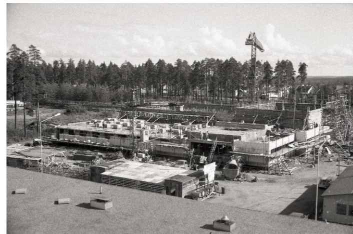
Kuva: Uimahallin rakennustyömaa. / Kuvaaja Reino Kaatonen 1971. Etelä-Karjalan museo.
