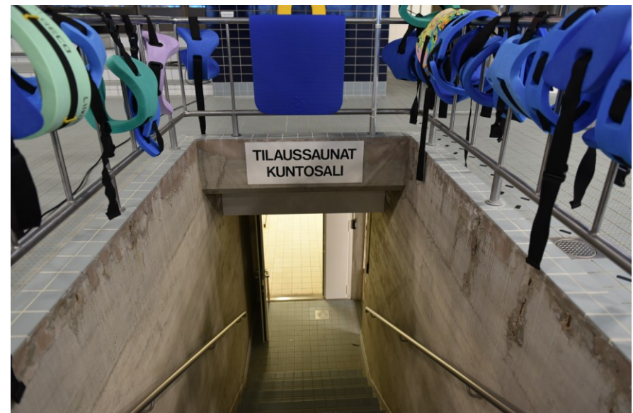
Kuva: Laatoitettu betoniporras vie allashallista kellarinkerrokseen.
