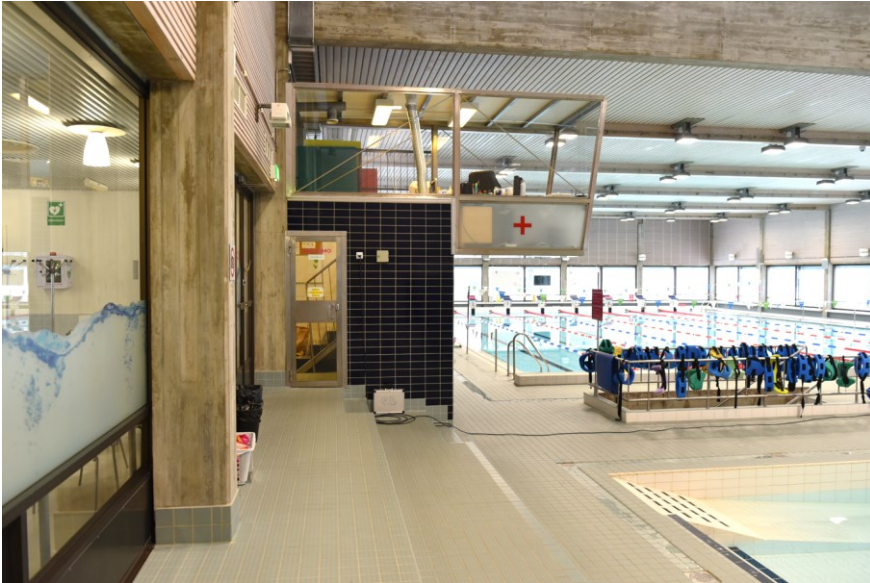
Kuva: Lattiatasossa ollut valvomo on nostettu ylemmäksi 1999. Allashallin lattioiden klinkkerilaatoitus on uusittu.
