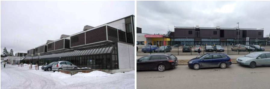
Kuva: Pohjolankatu. Urheilutalo ennen ja jälkeen peruskorjauksen. / KIOSKI, M. Pesu 2005; Str. View 2024.
