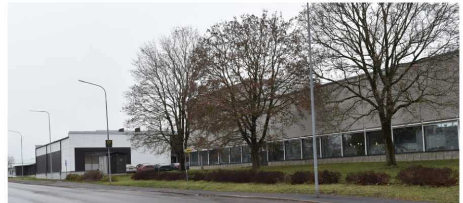
Kuva: Armilankatu. Urheilutalon laajennusosa ja uimahalli.
