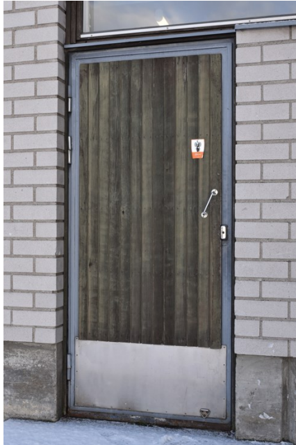
Kuvat: Alkuperäinen pystypaneloitu ovi.
