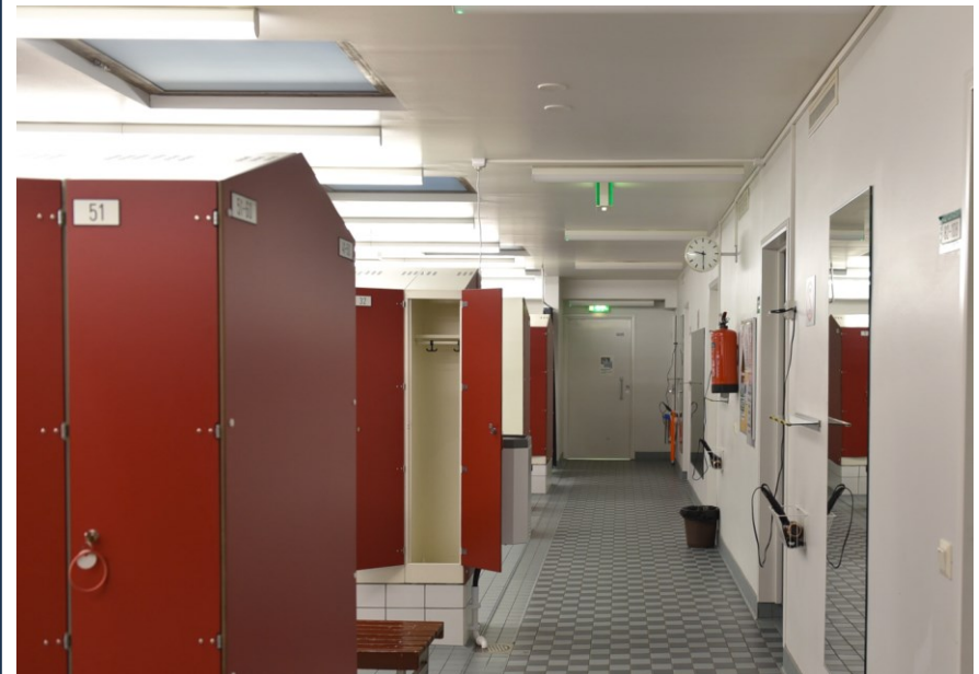
Kuva: Pukuhuone nykyasussaan. Pinnat ja värit uusittu. Betoniseinä on rapattu. Väliovia on uusittu, samalla vaihdettiin niiden avautumissuunta.
