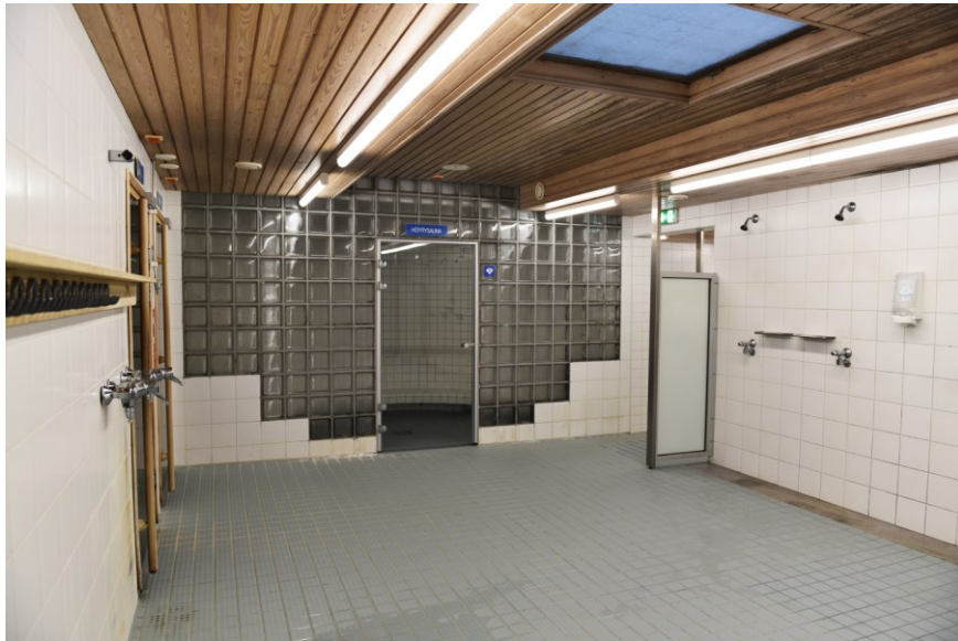
Kuva: Saunaosasto. Pintamateriaalit uusittu alkuperäisiä mukaillen. Lasitiiliseinäiset höyrysaunat rakennettiin peruskorjauksen yhteydessä 1999.
