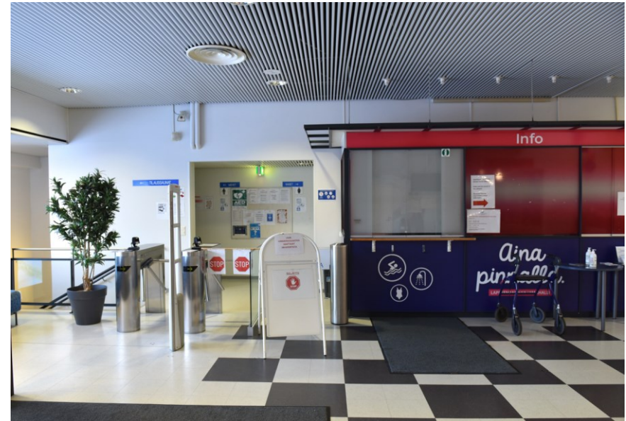
Kuva: Eteishalliin on rakennettu kevytrakenteinen kassa/valvomo-koppi. Sisäänkäynti hallista pukuhuoneisiin on yhdistetty yhteen kulkuaukkoon. Nykyinen alakatto on tehty säleikkönä.
