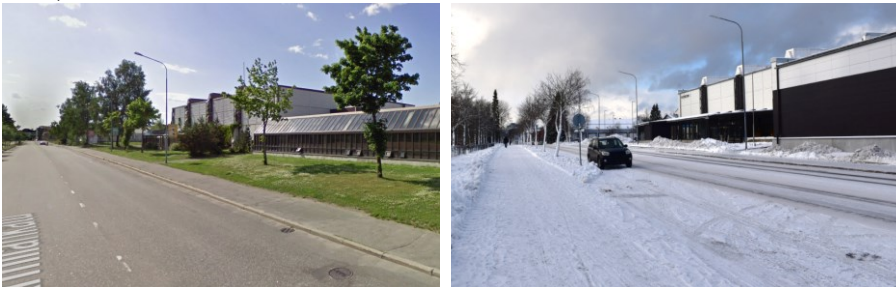
Kuva: Armilankatu. Urheilutalo ennen ja jälkeen peruskorjauksen. / Str. View 2009; Ahola 2024.
