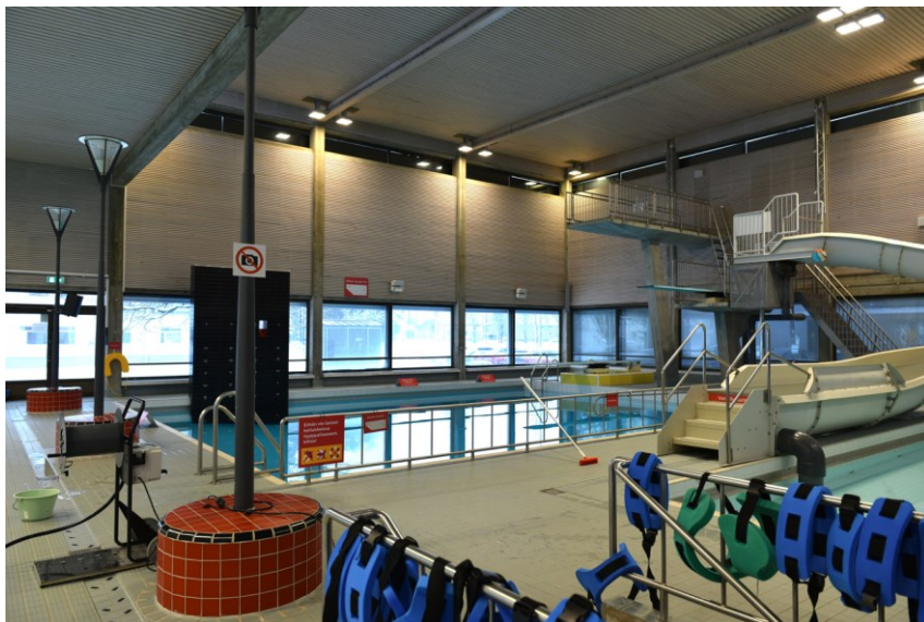
Kuva: Puuverhoilu uusittiin ja sen määrää lisättiin 1999. Nyt rimoitus peittää myös katon liimapuupalkit ja päätyseinissä näkyville jätetyn betonin. Puu on aikaisempaa vaaleampi. Hallin keskiosaan on tuotu valopylväät istuintasoiineen.
