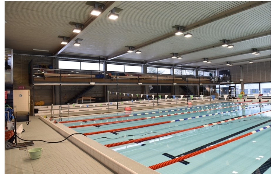
Kuva: Peruskorjauksen (1999) yhteydessä rakennettiin teräsrakenteinen ja lasikaiteinen yläkatsomo. Halliin tehtiin alakatto, joka sisään jäivät liimapuupalkit ja entinen loivan harjakaton muotoa myötäillyt laudoitus.
