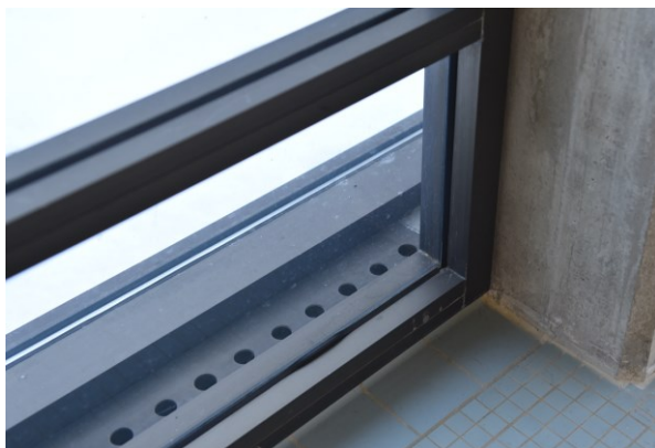
ALLASHALLIN IKKUNA, ENT. LÄMPÖKANAVAT
