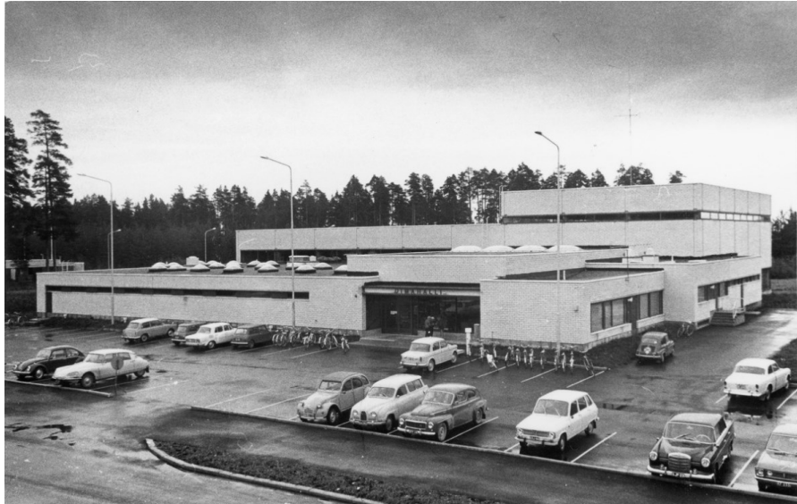
Kuva: Pohjoisjulkisivu. Yhtäjaksoiset kapeat nauhaikkunat kiertävät kulmien ympäri. Ikkunoiden sijoittaminen seinän ulkopintaa syvemmälle ja niiden puuosien tumma sävy lisää ulkoasuun graafista ilmettä. / Kuvaaja Mikonsaari, Aarne A., valokuvaaja 1972–1982 . Etelä-Karjalan museo
