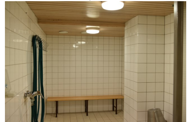
TAKKAHUONEEN SAUNA, PESUHUONE
