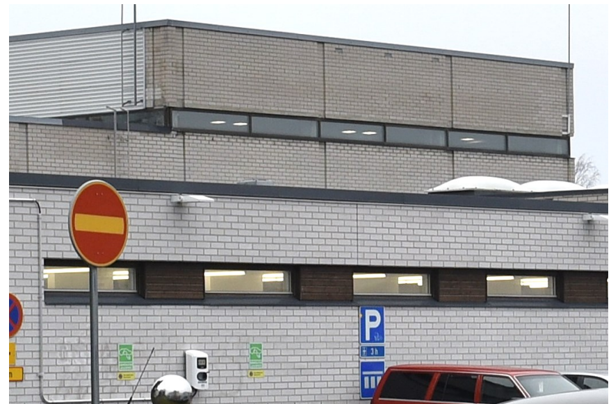
Kuva oikealla: Allashallin korkean osan kapea nauhaikkuna. Etualalla pukuhuoneen laajennus (1999), johon tehtiin vanhan julkisivun mukaiset ikkunat, mutta välisosan paneloinnin suunta muutettiin pystystä vaakaan.
