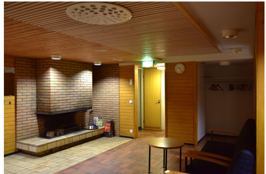
Kuva: Takkahuone nykyasussaan. Paneelikatto on uusittu, samoin valaisimet ja kalusteet sekä lattiapinta takan edustan vaaleaa laatoitusta lukuun ottamatta. Toisen oven paikalla on vaatenaulakko.
