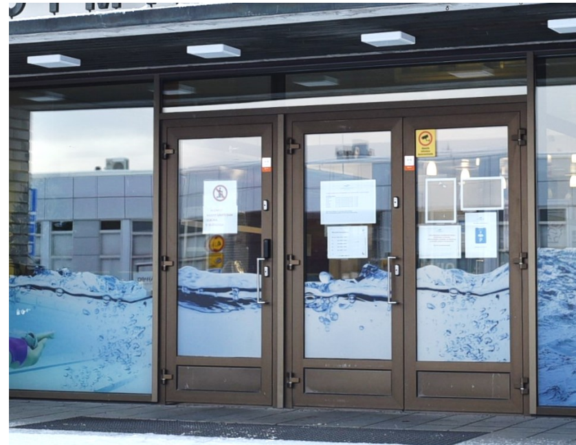
Kuva: Pääovi siirrettiin 1999 sijansa keskemmälle, samalla ovien määrää lisättiin yhdellä.
