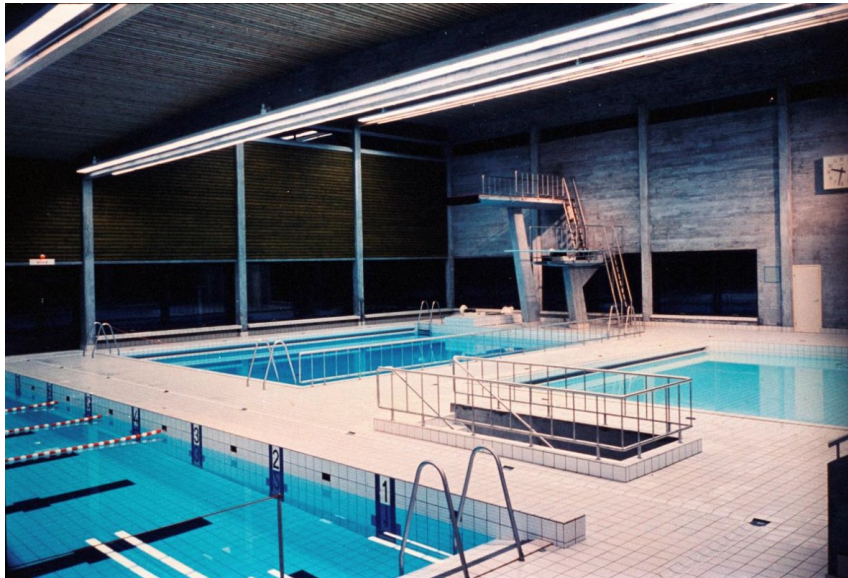
Kuva: Allashallin päätyseinät oli alun perin jätetty betonipinnalle, samoin teräsbetonipilarit joka seinällä. Sivuseinän yläosassa on kuultusävytetty rimoitus. / Kuvaaja Mikonsaari, Aarne A., 1973. EKM
