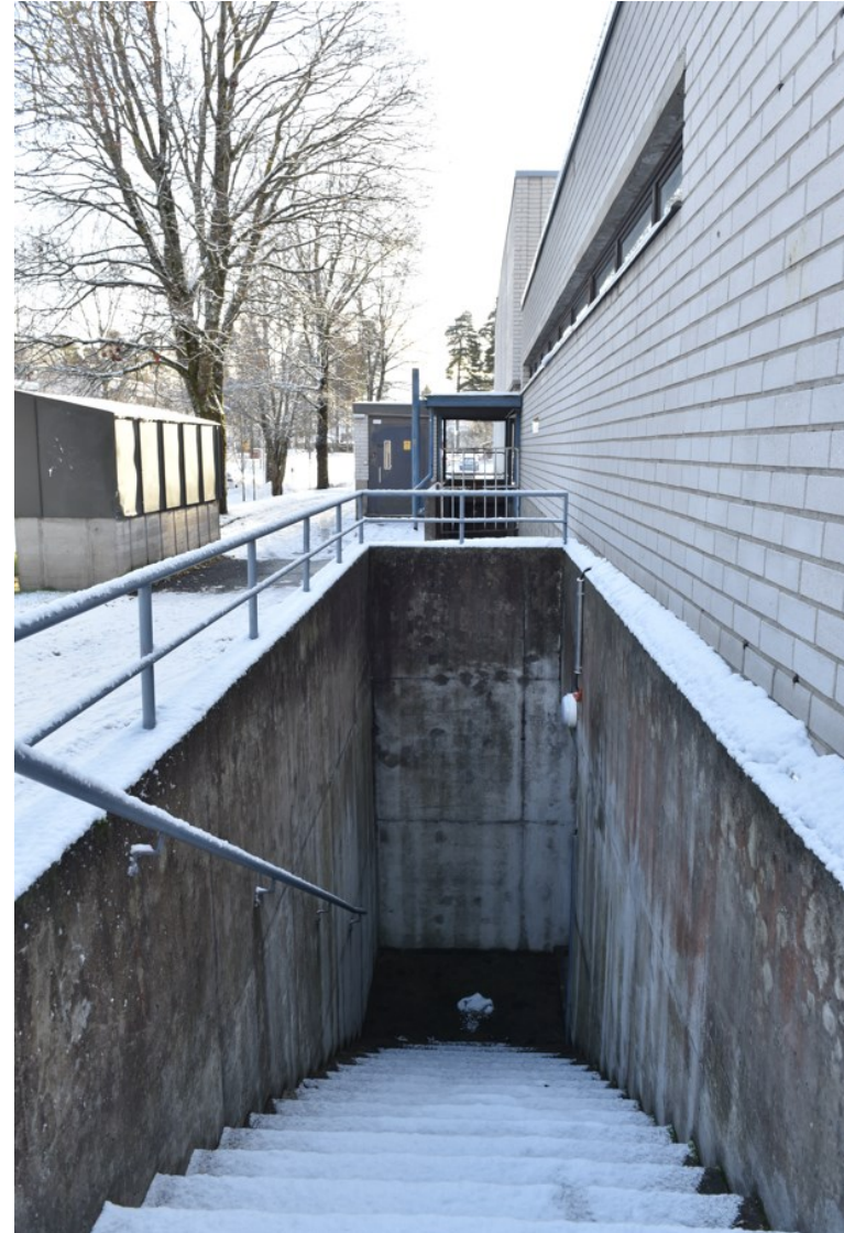
Kuva: Ulkoportaat kellarikerrokseen.
