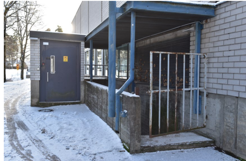
Kuva: 2000 valmistuneen peruskorjauksen yhteydessä vanha kellariporras katettiin ja sen viereen rakennettiin hissi.
