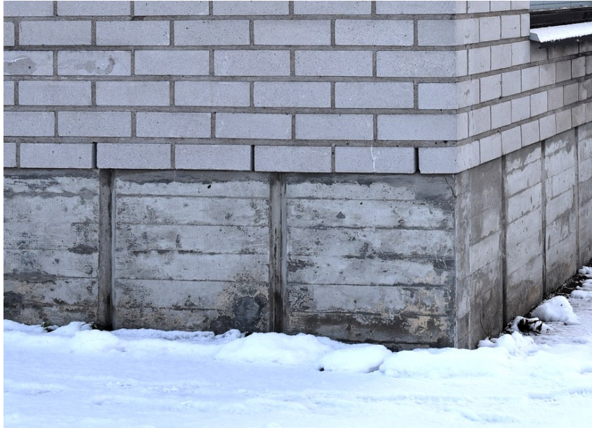
Kuva: Alkuperäinen pystyuritettu (katkot) betonisokkeli.
