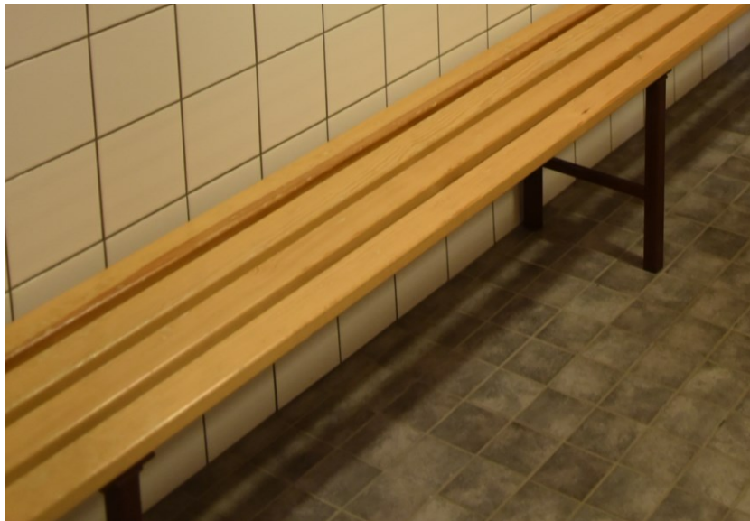
Kuva: Vanhaa ja uutta laatoitusta kellarikerroksen pesutilassa.
