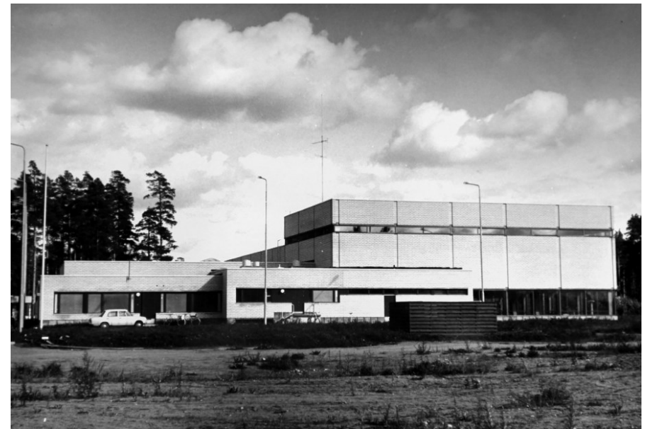
Kuva: Rakennuksen länteen avautuvassa julkisivussa oli sisäänkäynnit talonmiehen asuntoon (vasemmalla) ja keittiöön. / Kuvaaja P. Roiha 1972. Etelä-Karjalan museo.
