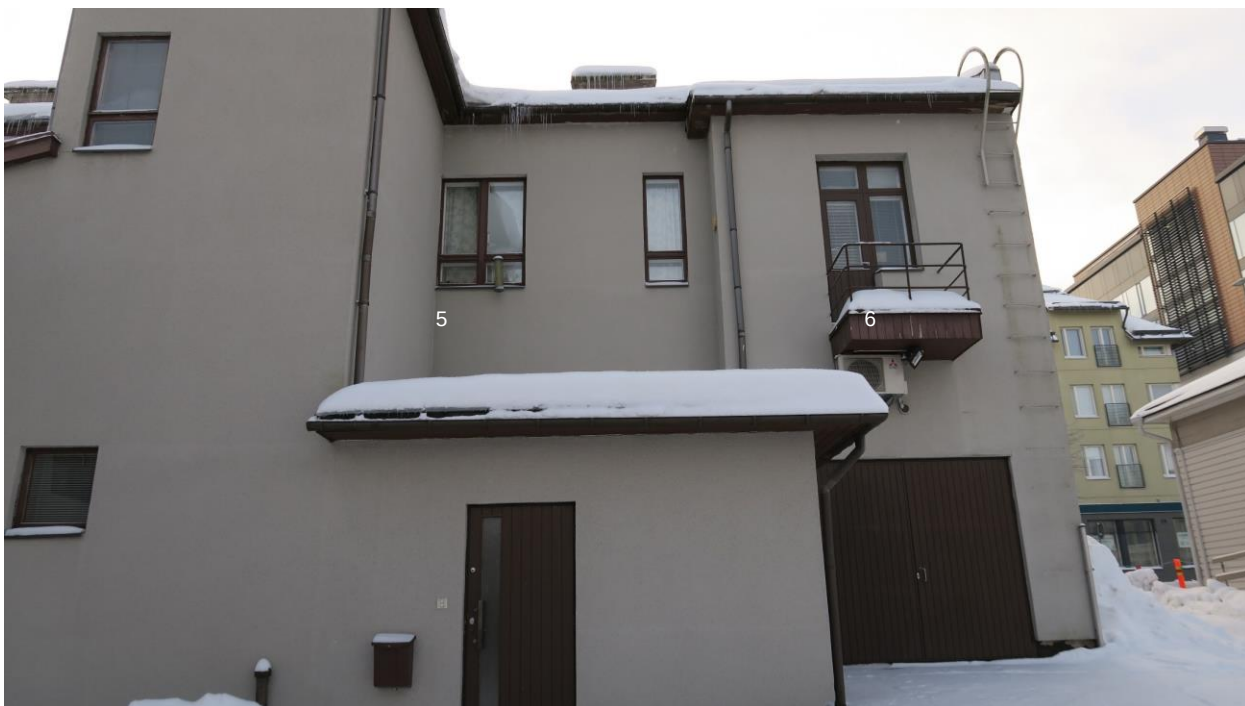
Kuva 130. Sisäpihalta etelään, pohjoissivu. Alaosan vanhan porttikongin paikalla on autotallin pariovet. Pihajulkisivun rappaus on sileämpi ja sävy eri kuin muualla julkisivuilla.
