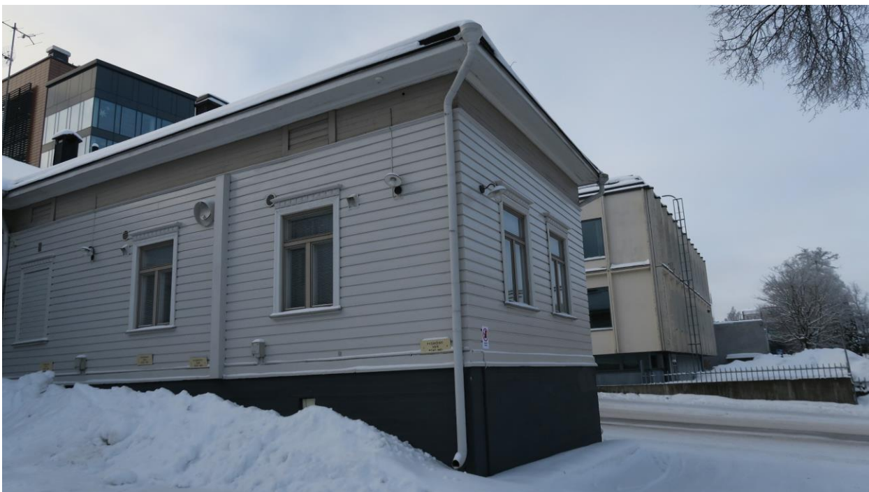
Kuva 95. Talon pohjoispääty ja laajennusosa 1920-luvulta. Korkea betonikivijalka.
