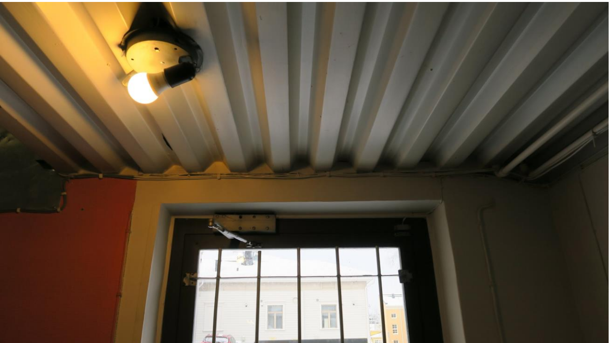
Kuvassa 158. Kellarin laajennusosan länsisivun ovi sisäpihalle.
