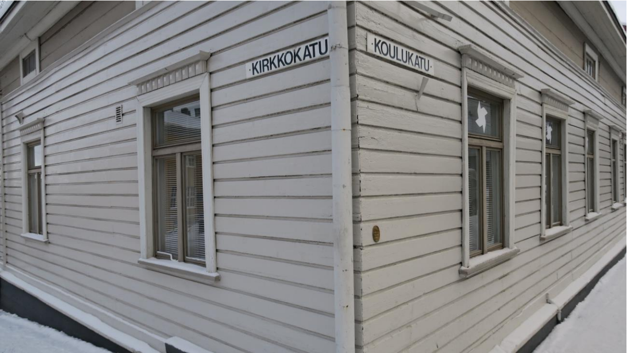
Kuva 97. Yksityiskohta talon nurkasta katujen kulmassa. Vaakaponttipanelointi, T- malliset ikkunapuitteet ja noppakoristein korostetut ikkunakehyslistat kiinnittävät huomiota.
