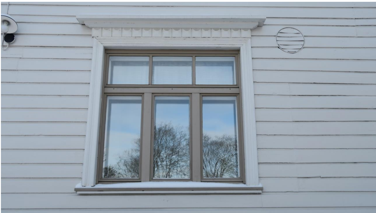
Kuva 100. Sisäpihan uusittu ikkunapuite vanhan 1900-luvun alkupuolen mallin mukaan.
