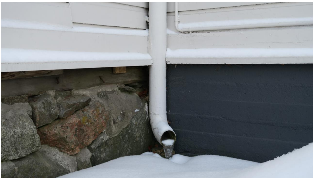
Kuva 99. Sisäpihalta vanhimman rakennuksen ja laajennusosan yhtymäkohta. Luonnonkivi ja betonia kivijalassa.
