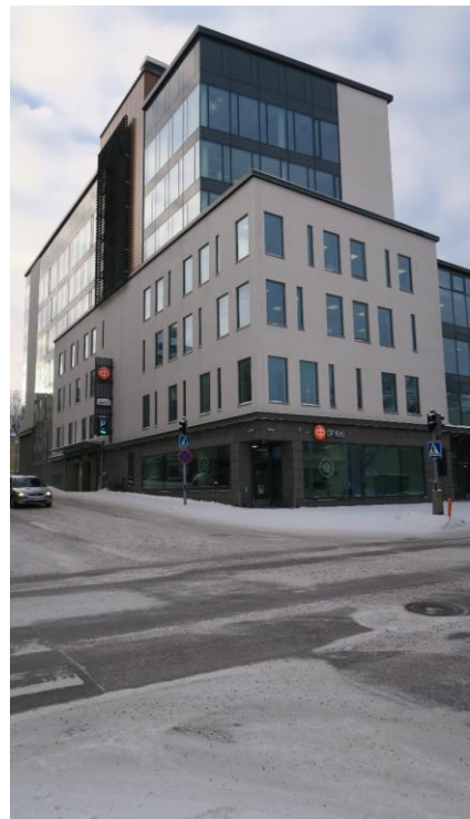
Kuva 167. kuva risteyksestä ja uudisrakennusta talvella 2021.
