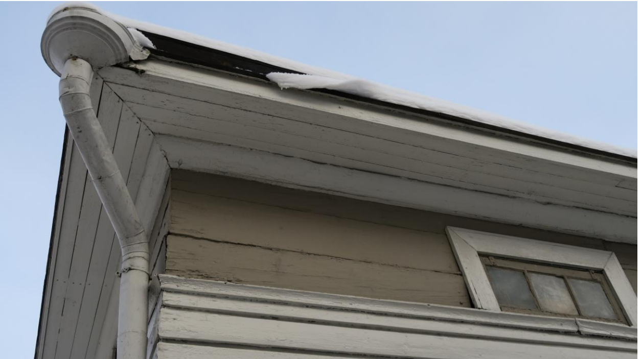
Kuva 98. Umpeen laudoitettu räystääналunen on viimeistelty simssilistan tapaan. Vinttikerroksessa on haukkaikkunat.
