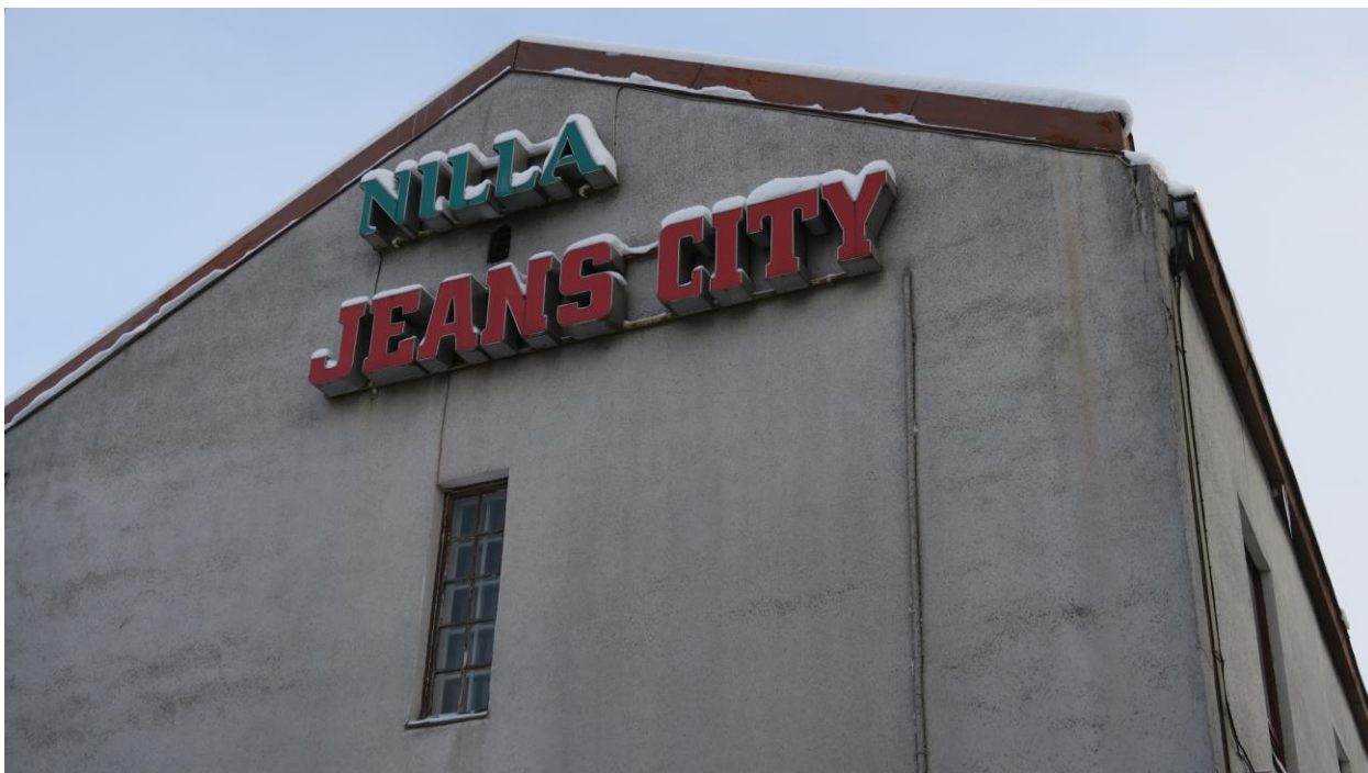
Kuva 129. Liiketalon länsipäädystä, jossa on säilynyt alkuperäinen 1930-luvun ikkunatyypin puitteineen sekä 1970-luvun valomainokset. Päädyissä ja eteläsivun toisessa kerroksessa on vanhempi rappauspinta kuin sisäpihalla.
