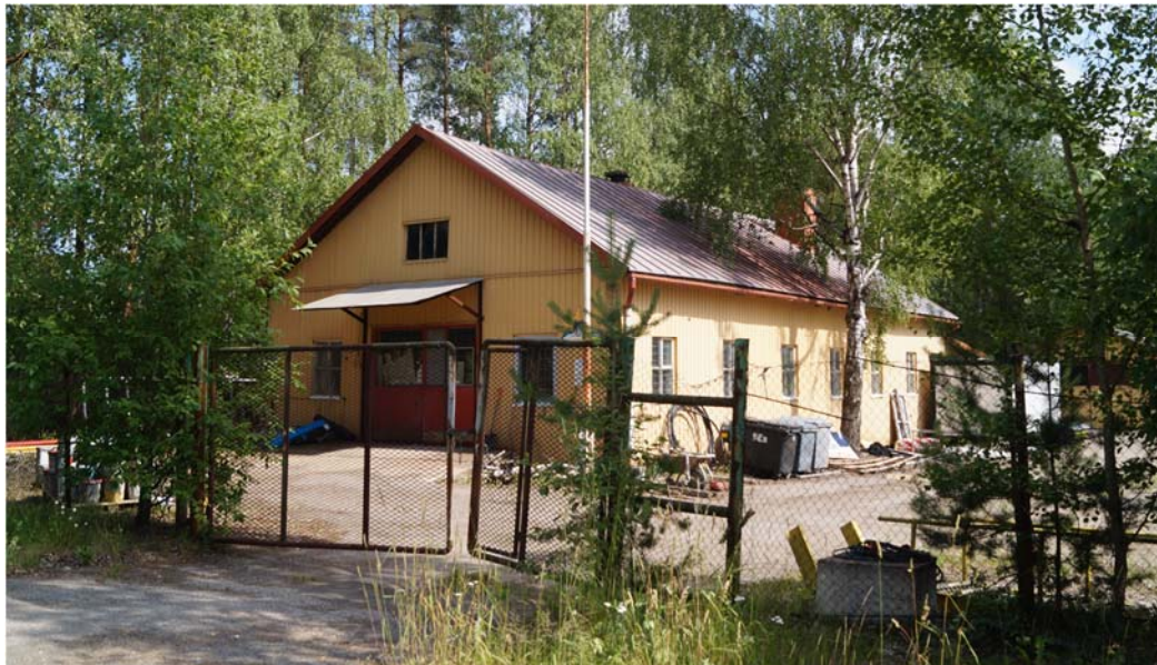
Kuva 8. Suunnittelualan pohjoispäässä oleva yksikerroksinen ja harjakattoinen teollisuus- ja varastorakennus.
