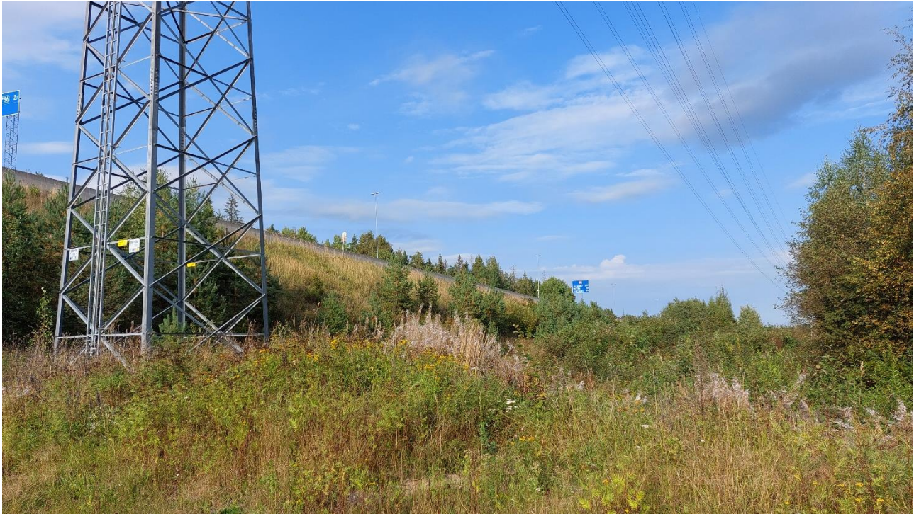
Kuva 4. Voimalinjan alla olevaa kasvillisuutta.
