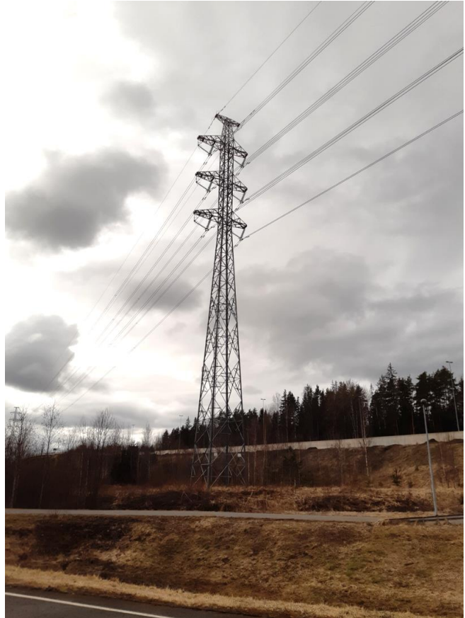
Kuva 12. Suunnittelualueen itäosan voimajohtopylväs matkailurampin pysäköintialueelta kuvattuna keväällä 2024.
