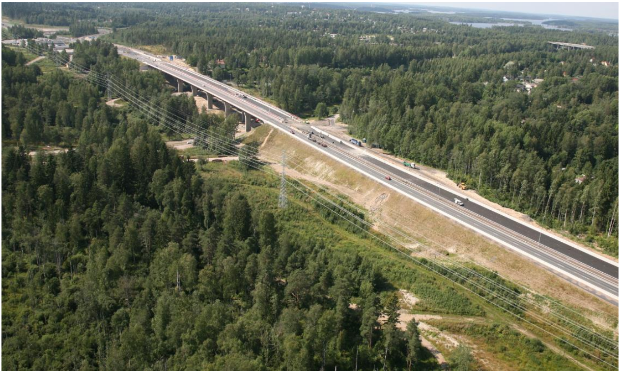
Kuva 14. Viistoilmakuva idästä suunnittelualueelle vuodelta 2010 nelikaistatien rakentamisen ajalta. Sittenmin voimajohdon pylväitä ja voimalinjaa on hieman muutettu suunnittelualueen länsipuolella Saimaan kanavan vastarannalla (kuvan vasemmassa yläkulmassa). Kuvassa näkyy suunnittelualueen länsiosassa oleva pylväis. © Lappeenrannan kaupunki.
