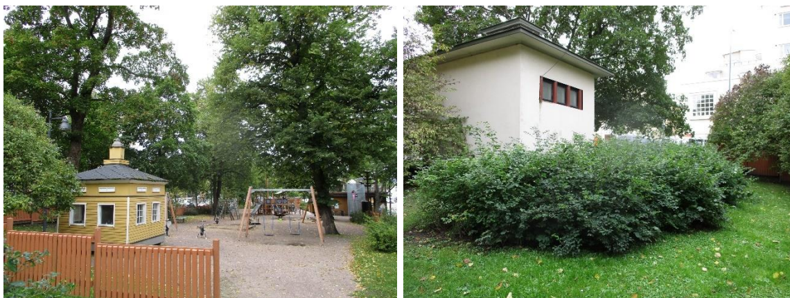
Kuvat 3 ja 4. Leikkipaikka ja muuntamo Rantapuiston länsiosassa.
