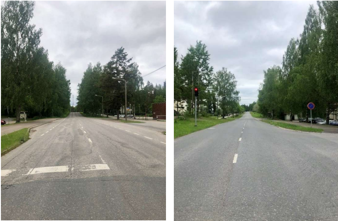
Kuva 19 Näkymä Voisalmentiestä. Vasemmanpuolinen kuva on pohjoiseen ja oikeanpuolinen etelään.
