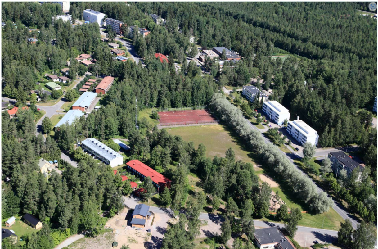
Kuva 9 Viistoilmakuva etelästä. Lappeenrannan kaupunki 2020.
