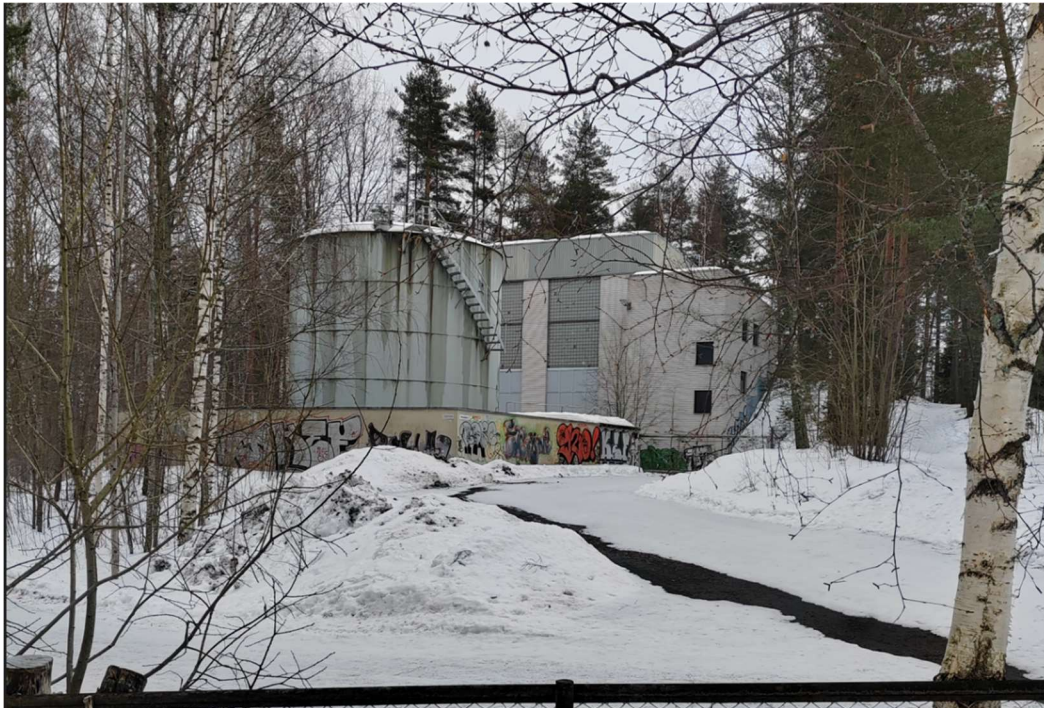
Kuva 16 Voisalmen käytöstä poistettu lämpövoimala (v.2024).
