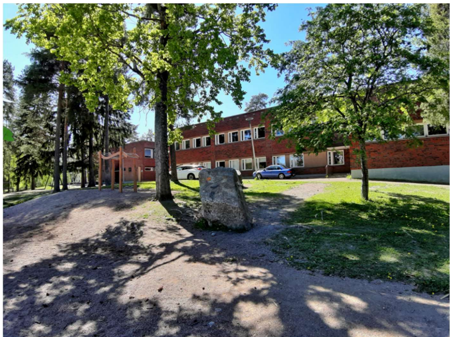
Kuva 12 Koulurakennus kuvattuna idästä (v.2020).
