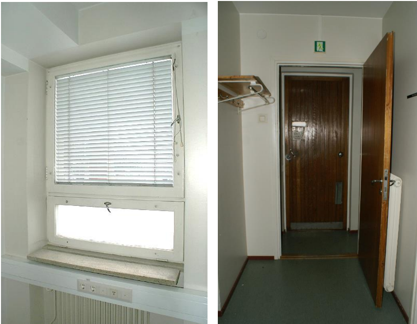
Kuvat: Vastaanottohuoneen ikkuna, radiaattori ja asutupuolen ulko- ja väliovi nähtävästi 50-luvulta.
