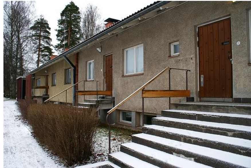
Kuva: Tietokadun puoleinen julkisivu, jossa 60-luvun laajennuksen erottaa vanhasta osasta rappauksen sävyn, ikkunoiden puitejaon ja -värin ja portaikon suunnan ja suojaseinäkkeen perusteella.
