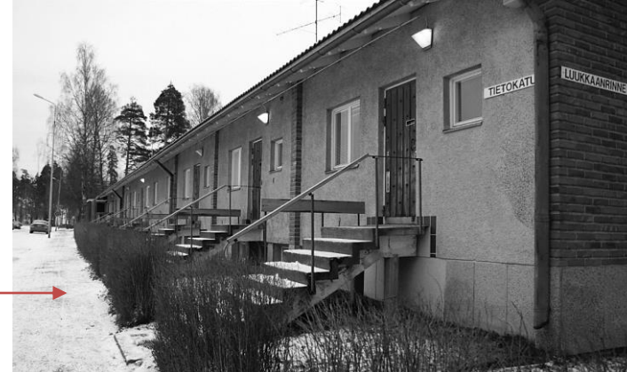
Kuva: Terveystalo vuonna 2016. Itäfasadi. Kaikkien ulkoportaiden kaiteet (teräs, johteena tammilankku) ovat 60-luvulta. 21
