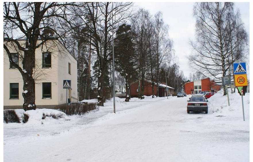
Kuva: Matala pitkä rakennus ei nouse vahvasti esille Tietokadun ympäristössä, kookkaampien kivirakennusten keskeltä.
