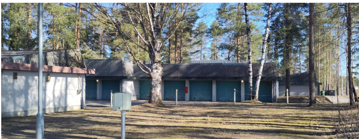
Kuva 22. Vierasmajan pihapiirin autotalli- ja talousrakennukset.
