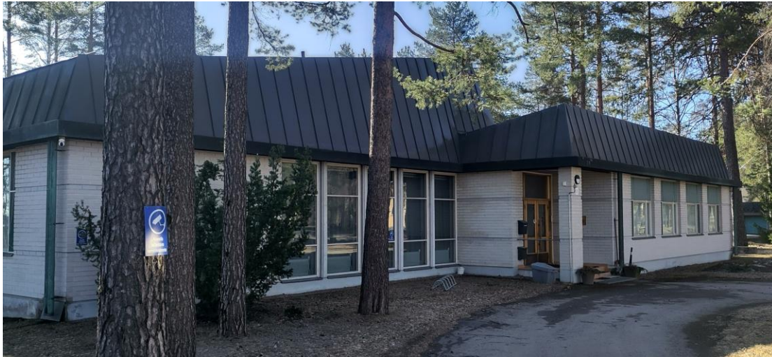
Kuva 21. Vierasmaja edustaa 1960-luvun rakentamista.
