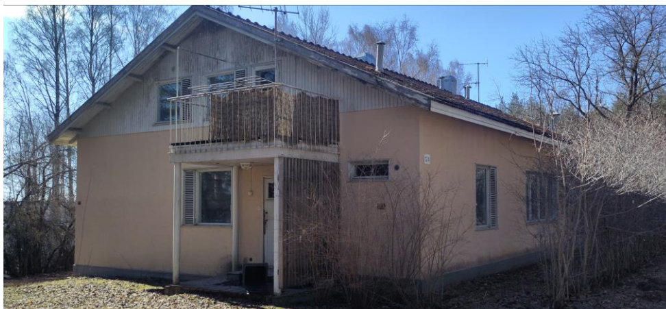
Kuva 33. Paraistentie 12:ssa sijaitsevan rakennuksen pohjoispäädyt.
