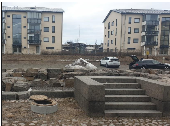
Kuva 2. Mittauspiste MP3. Mittarit suojattiin kuvassa näkyvin rakentein.
