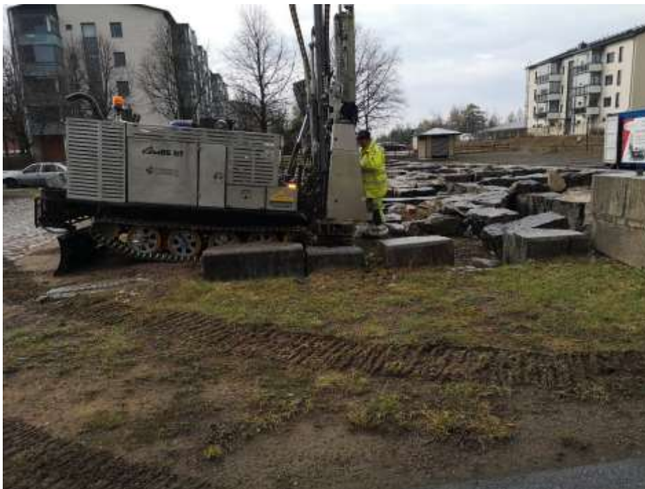
Kuva 6. Kairapiste P1 sijoitettiin kivijalan sisäpuolelle.
