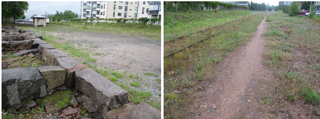
Kuvat 3 ja 4. Niukkaa kasvillisuutta kivijalan kivien ympärillä ja radan varressa.
