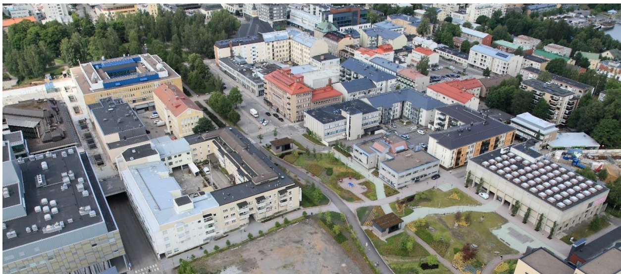
Kuva 35: Kuvan oikeassa alakulmassa pääkirjasto, seuraavana vasemmalla Anni Swannin katu, seuraavana Paasikiven puistoon rajautuvat nuorisotila Monari ja Kiinteistö Oy Pormestarintori, jonka oikealla puolella Asunto Oy Valtakatu 43 sekä suunnittelualan ulkopuolelle jäävä Asunto Oy Rutinkulma. (Lappeenrannan kuvapalvelu)
