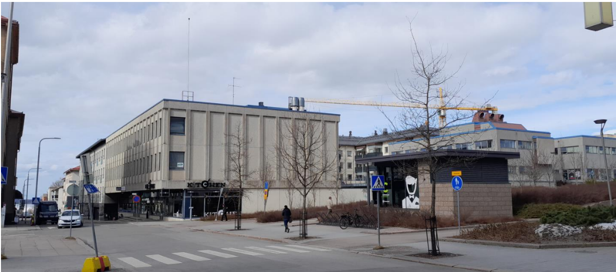
Kuva 3: Näkymä Raatimiehenkadulta kohti pohjoista ja Saimaata, keskellä kuvaa Pormestarintori, oikealla pysäköintilaitos P-Pormestarin porrashuone, takana ”Monari” ja Asunto Oy Rutinkulma. (Lappeenrannan kaupunkisuunnittelu 2022)
