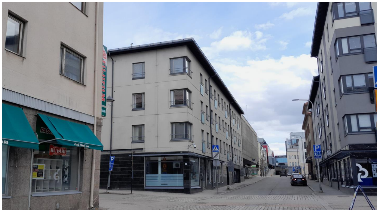
Kuva 18: Näkymä 12 metriä leveältä Raatimiehenkadulta kohti etelää, vasemmalla Asunto Oy Valtakatu 50, seuraavana Valtakatu, Asunto Oy Valtakatu 43, Kiinteistö Oy Pormestarintori, Asunto Oy Raatikara ja päätteenä kauppakeskus Iso Kristiinan sisäänkäynti. Oikealla Asunto Oy Kulmatalo, Viljelytalo ja Lappeenrannan oikeustalo. (Lappeenrannan kaupunkisuunnittelu 2022)
