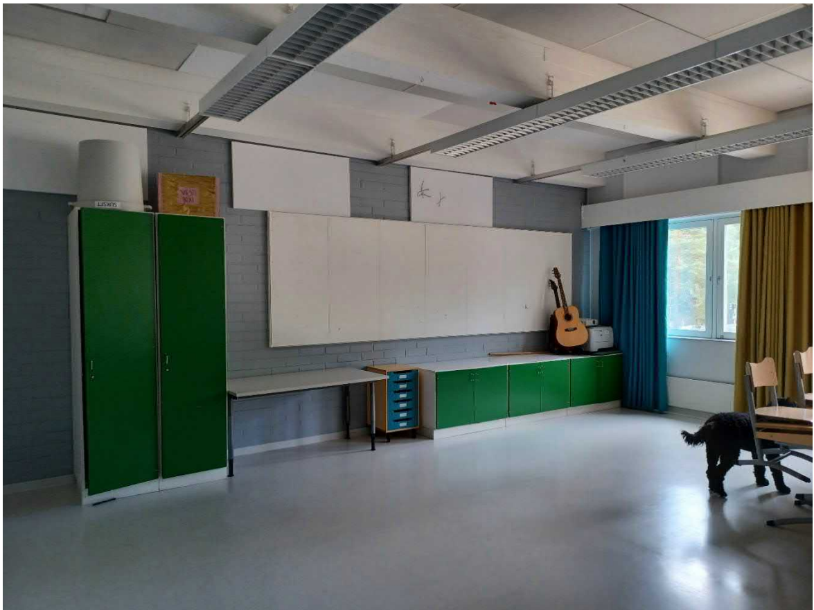
Kuva 122 2. kerroksen luokkahuoneita. Lattiapinnat ovat yläkuvissa alkuperäiset, alakuvan luokkahuoneessa uusittu muovimatto. Seinäpintoja on uudistettu maalaamalla. Katossa ovat teräsbetonipalkit näkyvissä.
