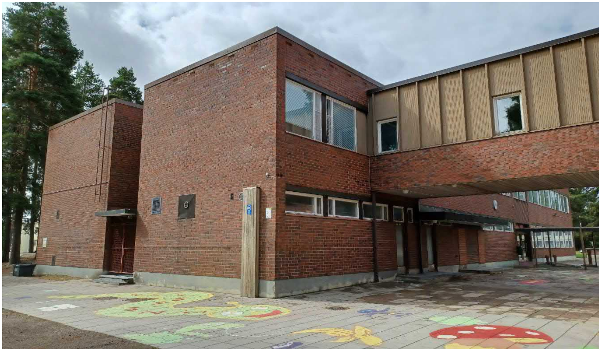
Kuva 67 Rakennus 1:n idän puoleinen pääty, pohjoisjulkisivu ja yhdyskäytävä. 50x50 cm kokoiset betonilaatat kiertävät rakennusten julkisivuja, ja sisäpiha on päällystetty laatoin. Yhdyskäytävän seinien yläosa on vaaleanruskeaksi maalattua peltiä. Kaikkien sisäänkäyntien yllä on yksinkertainen, koteloitu ja peltivuorattu lipa.
