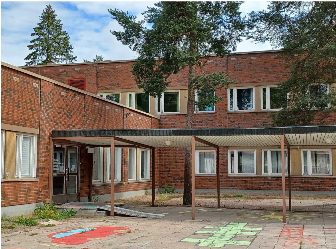
Kuva 88 (Ylä- ja alakuvassa) laatoitettua sisäpihaa sekä pihan läpi rakennusten välillä kulkeva "väli-tuntikatos".
