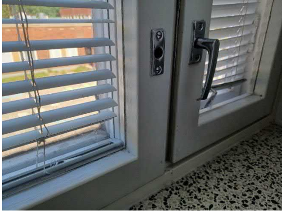
Kuva 96 Vanhan osan ikkunalaudat ovat mustavalkosävyistä mosaiikkibetonia ja ikkunanpuitteet täyspuiset.
