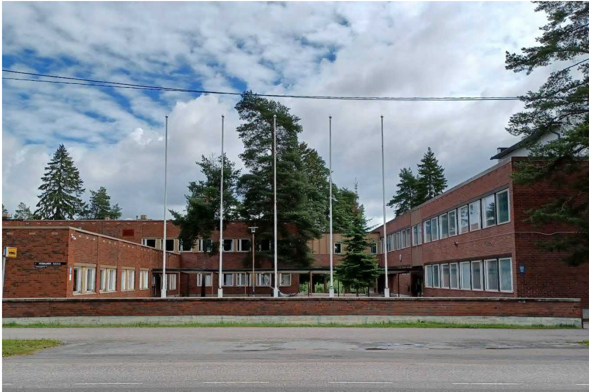
Kuva 26 Näkymä koulun pihaan Voisalmentien toiselta puolen. Oikealla koulun vanha osa, vasemmalla uusi osa ja keskellä rakennusten välinen yhdystunneli. Koulun sisäpihaa reunustaa matala tiili-muuri.
