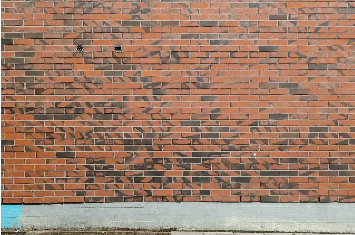
Kuva 75 Tiilijulkisivujen eläväinen pinta on saatu aikaan polttovaiheessa. Tällainen kuviointi on tiilijulkisivuissa harvinainen.
