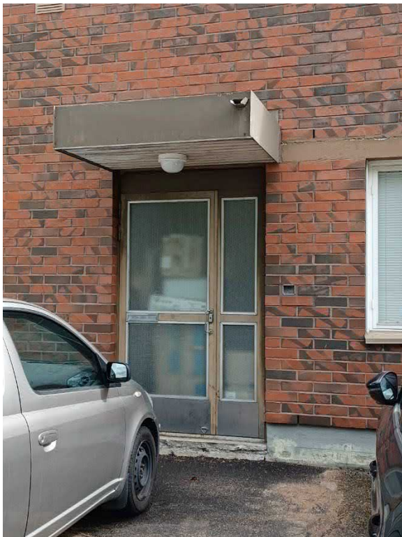
Kuva 84 Entisen vahtimestarin asunnon sisäänkäynti on katettu koteloidulla lippakatoksella.
