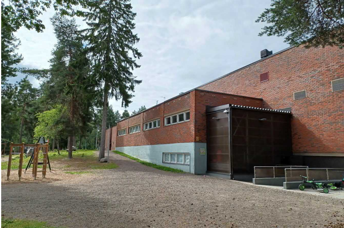
Kuva 77 Idän puolen matalan siiven kylkeen on vuonna 2017 rakennettu ulkopuolinen portaikko sekä luiska, joka johtaa kellarissa sijaitseviin esiopetustiloihin.
