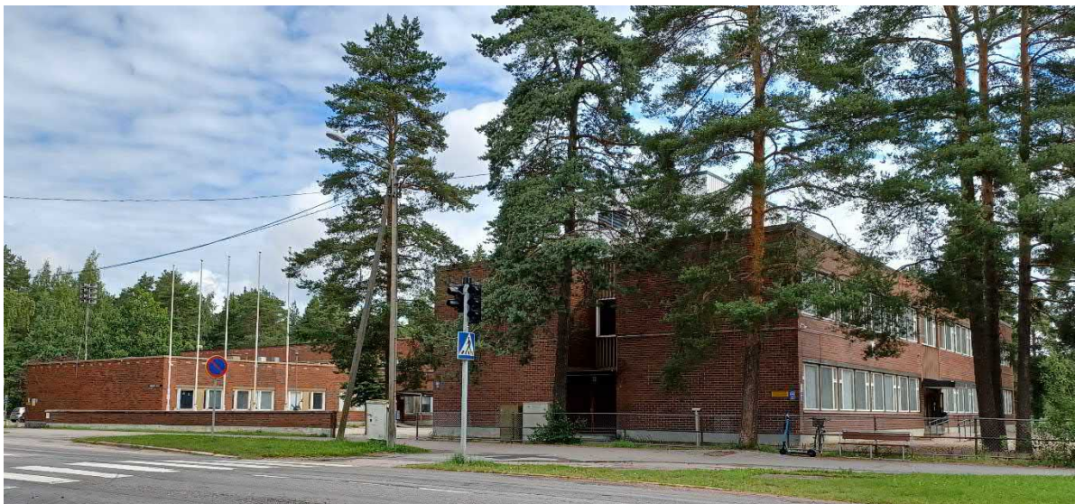
Kuva 3 Voisalmen koulurakennukset Voisalmentielle kuvattuna. Vuonna 1971 valmistunut rakennus 1 kuvassa oikealla, ja vuonna 1978 valmistunut rakennus 2 vasemmalla.
