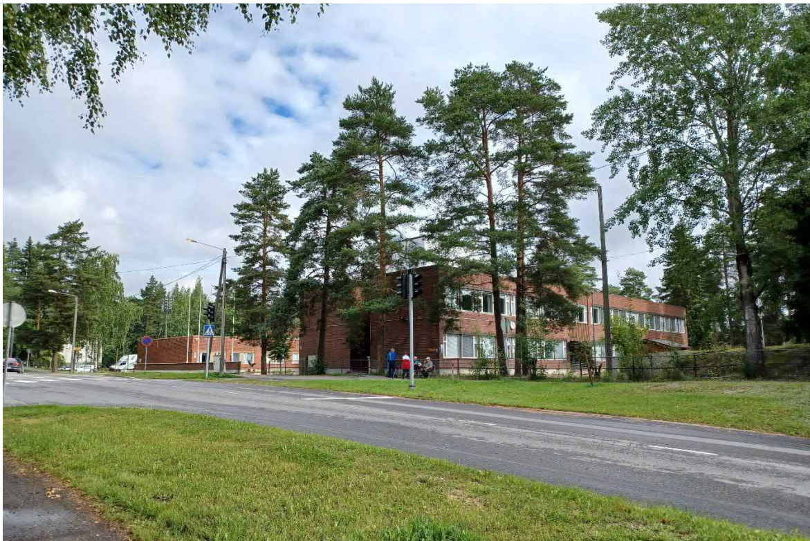
Kuva 27 Koulu kuvattuna Voisalmentien yli, lounaasta koillisen suuntaan. Etualalla rakennus 1 ja taaempana rakennus 2.
