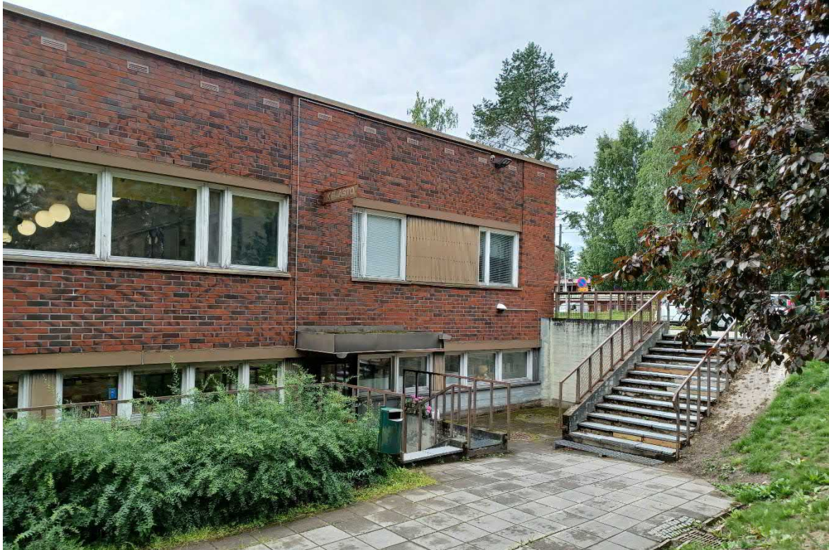
Kuva 81 Kirjaston yläpuolella sijaitsee alun perin vahtimestarin asunto. Kirjastoon pääsee joko portaista, tai esteettömästi rakennuksen vierellä olevaa luiskaa pitkin.
