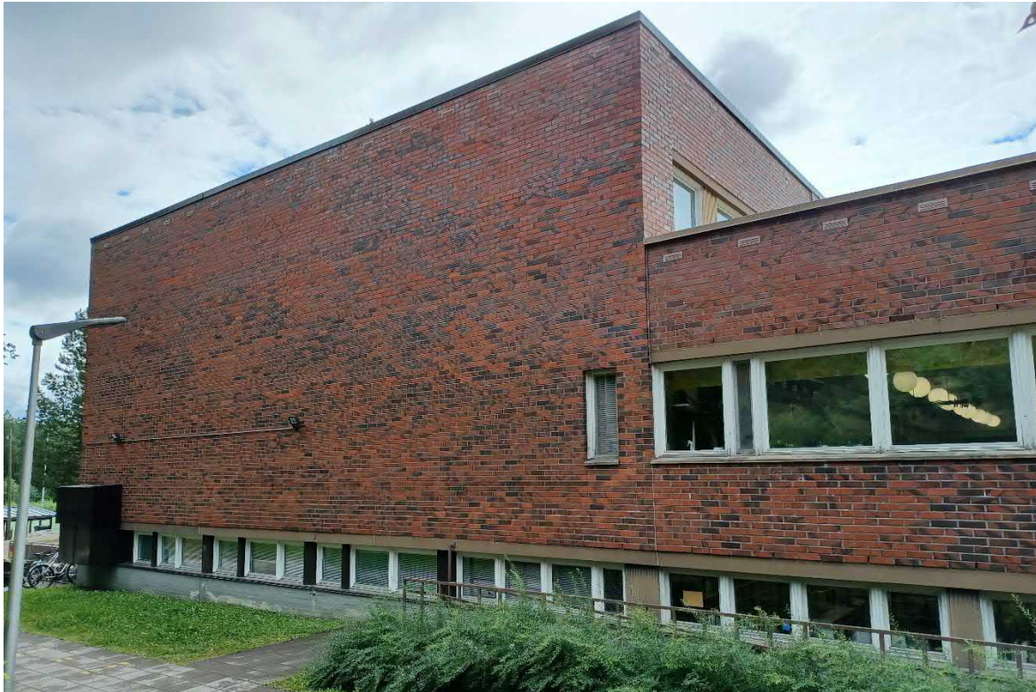
Kuva 83 Pohjoisjulkisivu, jossa on liikuntasali ja ruokala, ja näiden alapuolella esiopetustilat sekä kirjasto.
