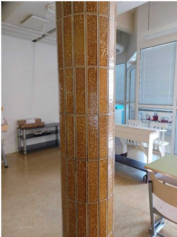
Kuva 95 Rakennuksen ylä- ja ala-aulatilan koristeellisena detaljina toimii pyöreä, laatoin pinnoitettu pylväs, joka läpäisee 1. ja 2. kerrokset. Ala-aulan pylväs on yläkerran pylvästä jyrkempi.
