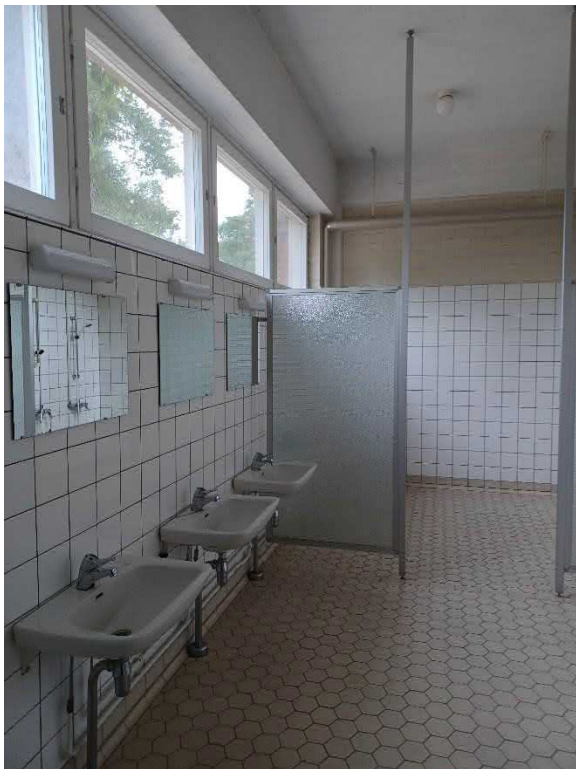
Kuva 118 Pukuhuone ja suihkuhuone rakennuksen itäpuolella matalassa siivessä. Pukuhuoneen lattia on uusittu, muut pinnat ovat alkuperäiset, niitä on lähinnä uudelleenmaalattu. Valaisimet ovat alkuperäiset. Suihkuhuone on pääosin alkuperäisasussaan. Vesipisteet ja niiden valaistus on uusittu.
