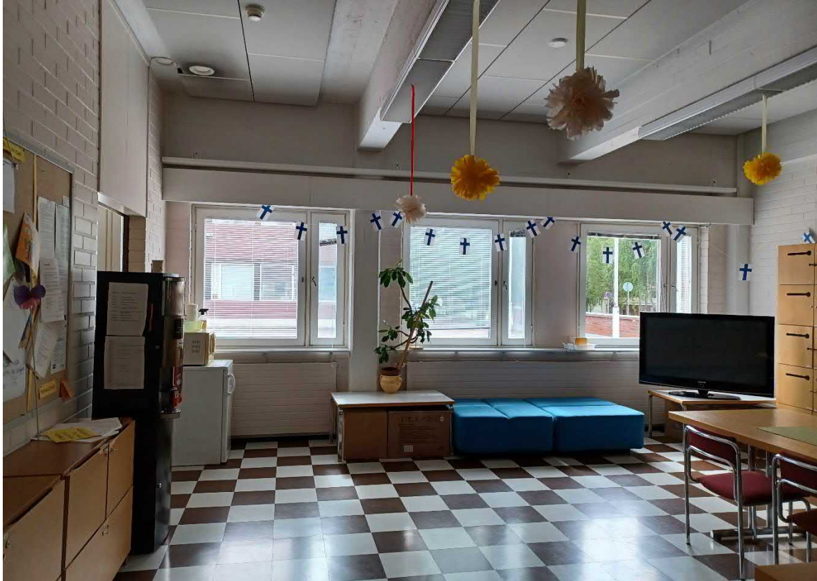
Kuva 109 Opettajien huone. Kantavat rakenteet ovat osittain näkyvissä, kuten tässä kattopalkistot.
