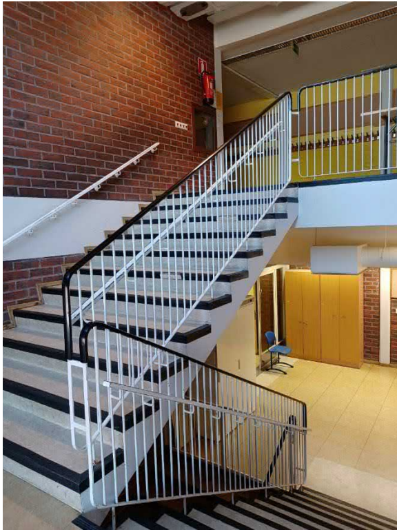
Kuva 100 Portaikon pinnakaiteet ovat alkuperäiset, mutta askelmien muovimattopinnoite on uusittu.
