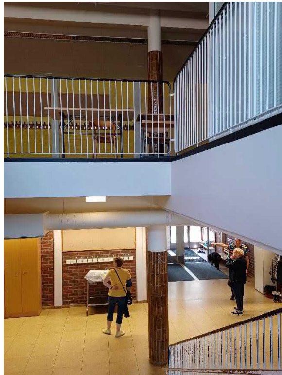
Kuva 95 Rakennuksen ylä- ja ala-aulatilan koristeellisena detaljina toimii pyöreä, laatoin pinnoitettu pylväs, joka läpäisee 1. ja 2. kerrokset. Ala-aulan pylväs on yläkerran pylvästä jyrkempi.
