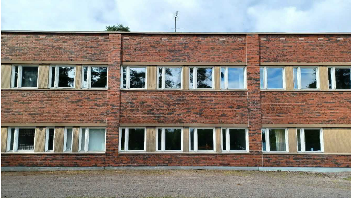
Kuva 73 Idän puoleista julkisivua. Nauhaikkunoita rytmittävät vaalean ruskealla maalatut profiilipeltiyksityiskohdat.
