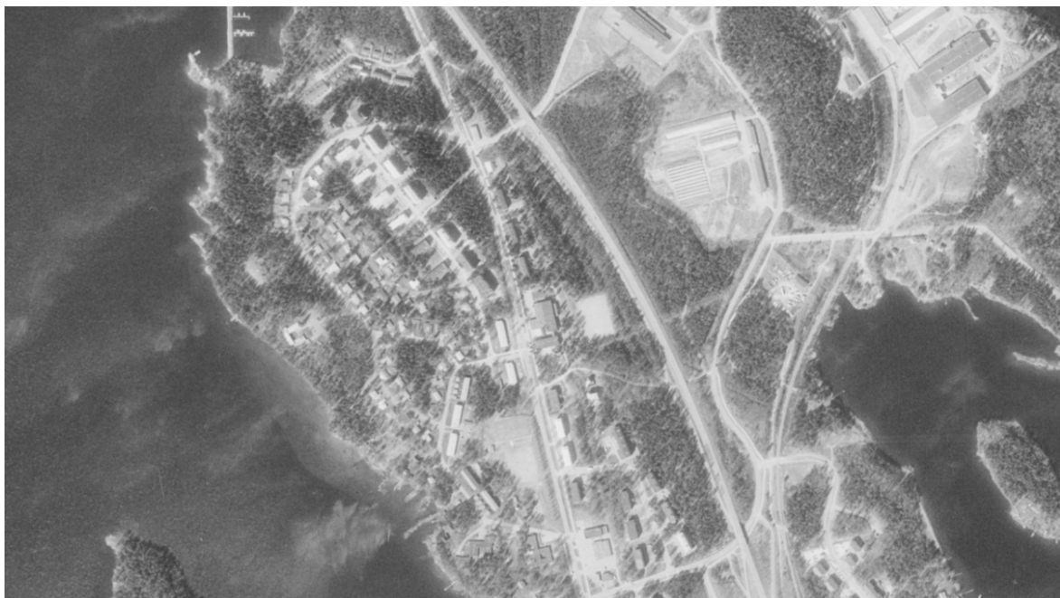
Kuva 21 Vuoden 1994 ilmakuvassa näkyy Metsä-Saimaan tehdasalueen laajeneminen koulun suuntaan. MML/Paikkatietoikkuna. Historialliset ilmakuvat.
