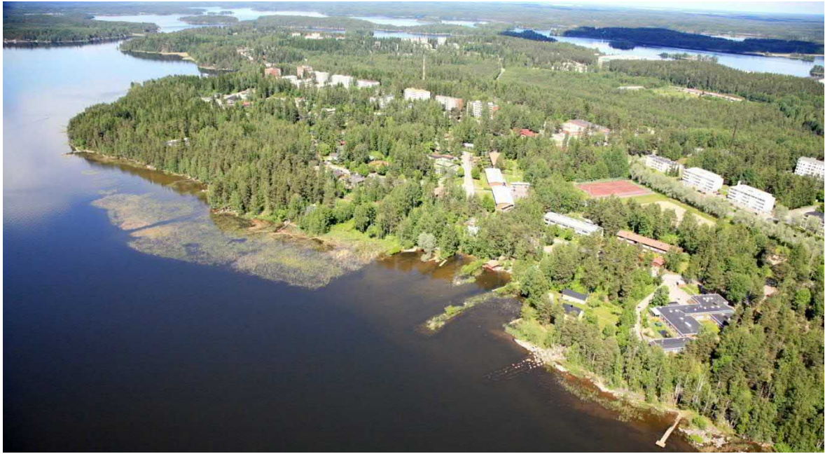
Kuva 22 Ilmakuva vuodelta 2009. Voisalmen koulu näkyy oikeassa yläaidassa kolmen kerrostalon vieressä. Lappeenrannan kaupunki.
