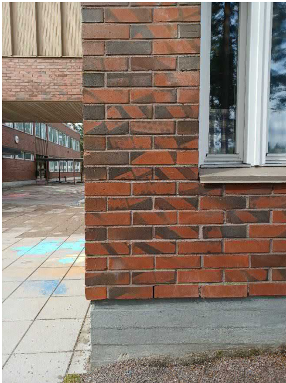
Kuva 74 Sokkeli on tehty muottivalutekniikalla.
