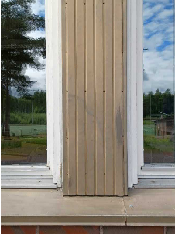
Kuva 89 Vasemman puoleisessa kuvassa profiilipeltiä, jota on käytetty detaljeissa. Oikean puoleisessa kuvassa sisäänkäynnin vieressä oleva alkuperäinen valaisin.
