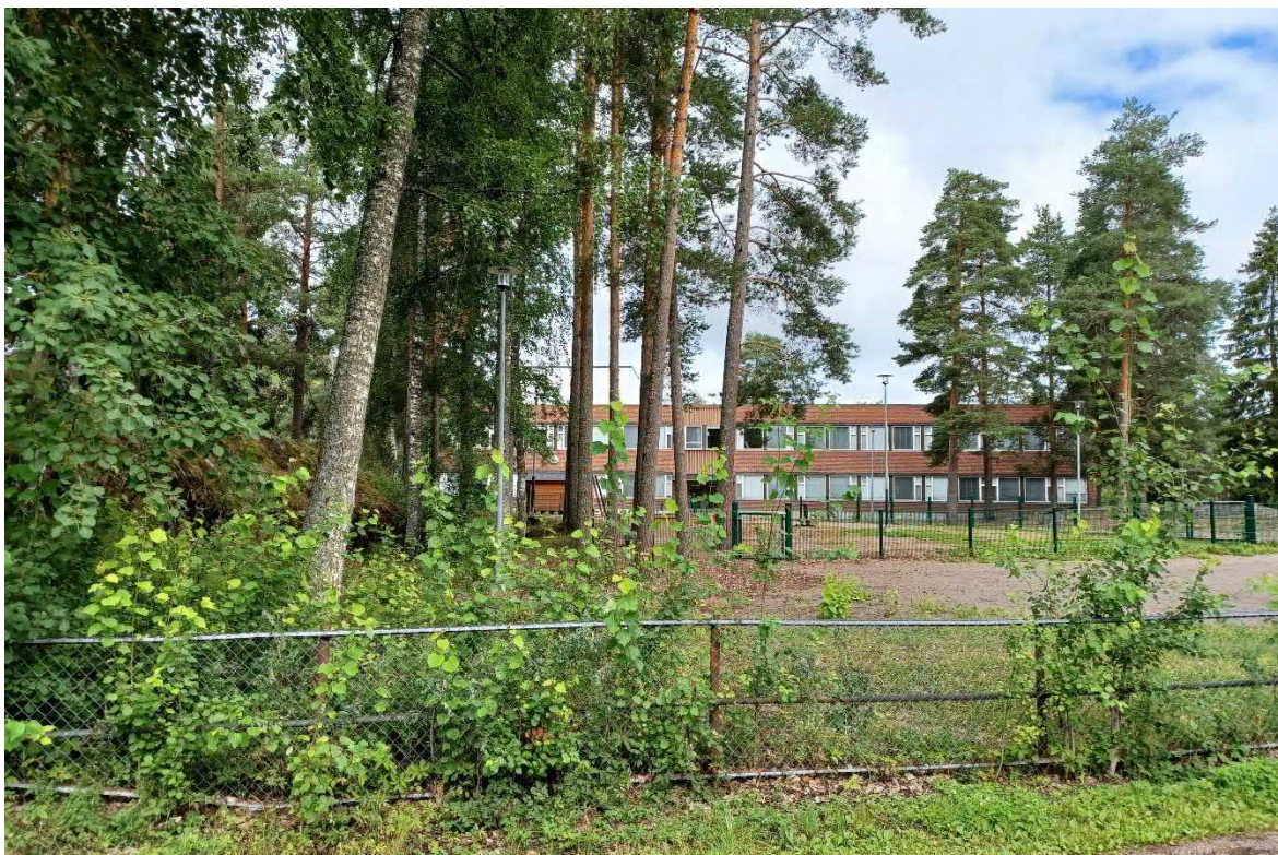
Kuva 28 Näkymä koulun tontin eteläpuolelta kohti vanhaa osaa. Etupiha on aidattu portilla varustetulla aidalla.
