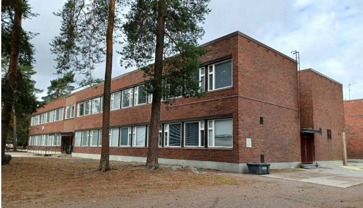
Kuva 66 Rakennus 1. Sisäänvedetty sisäänkäynti rakennuksen päädyissä jakaa rakennuksen pituussuunnassa kahteen rinnakkaiseen massa. Nauhaikkunoita rytmittävät maalatut profiilipeltidetallit.
