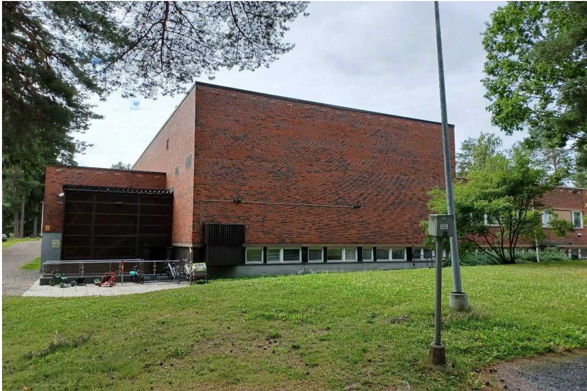
Kuva 79 Pohjoisjulkisivu. Korkeassa osassa sijaitsee kahden kerroksen korkuinen juhla- ja liikuntasali, jonka alapuolella ovat esiopetustilat.
