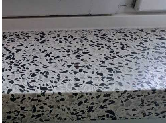
Kuva 96 Vanhan osan ikkunalaudat ovat mustavalkosävyistä mosaiikkibetonia ja ikkunanpuitteet täyspuiset.
