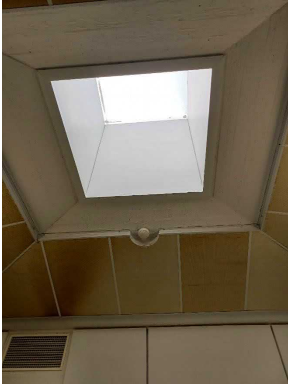
Kuva 116 Suureen ruokalasaliin pääsee luonnonvaloa päädyn suurten ikkunoiden lisäksi muutamista kuplamallisista kattoikkunoista, joista tosin osa on peitetty. Katossa on akustiikkalevyä.
