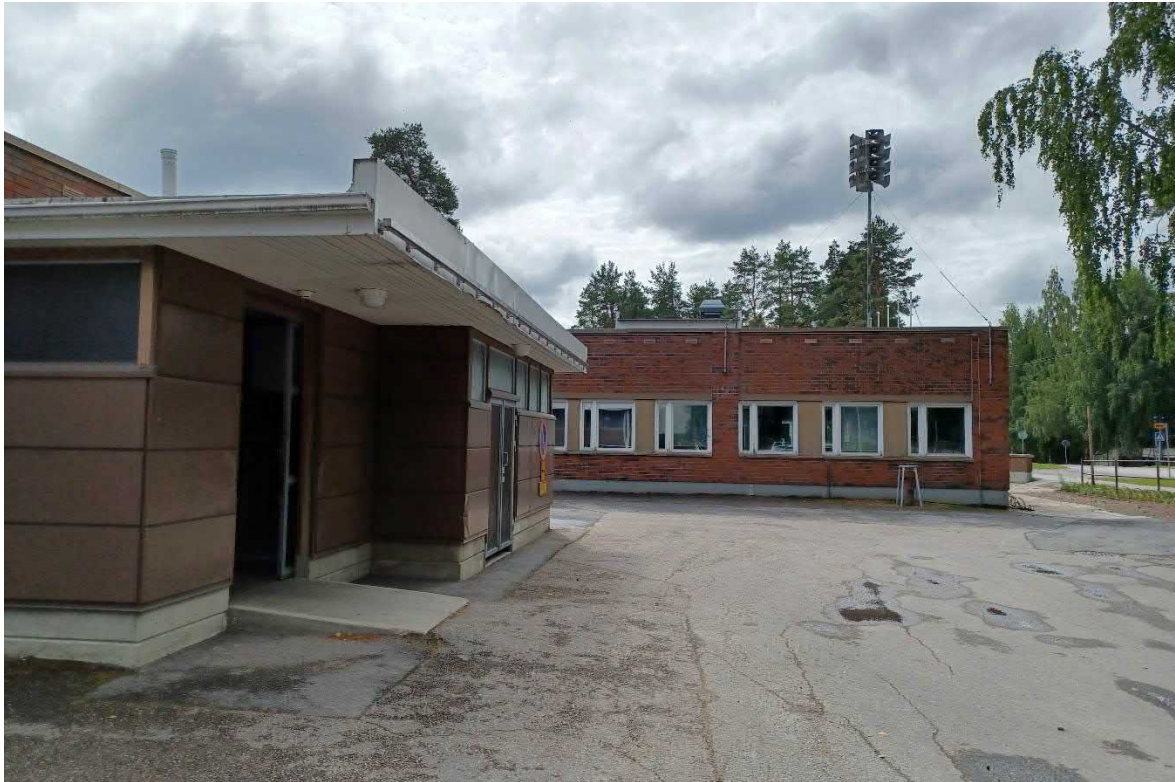
Kuva 85 Rakennuksen länsipuolelle on tehty uudisosa (vasemmalla), johon on sijoitettu jätekatos.
