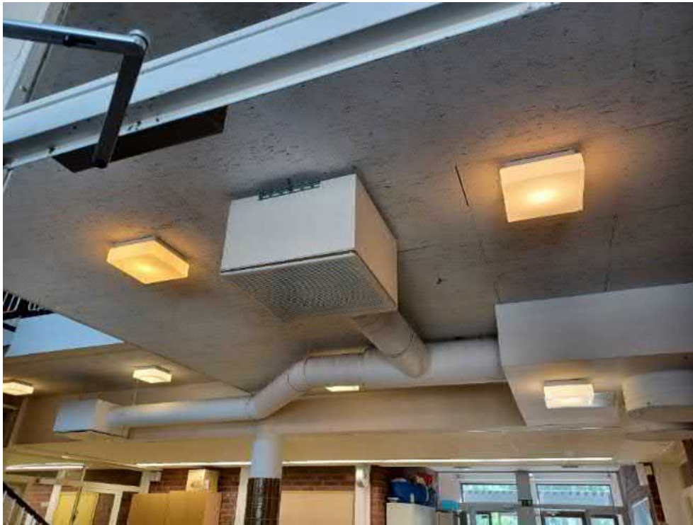
Kuva 105 Alkuperäisiä valaisimia ja akustiikkalevyjä aulatilassa.
