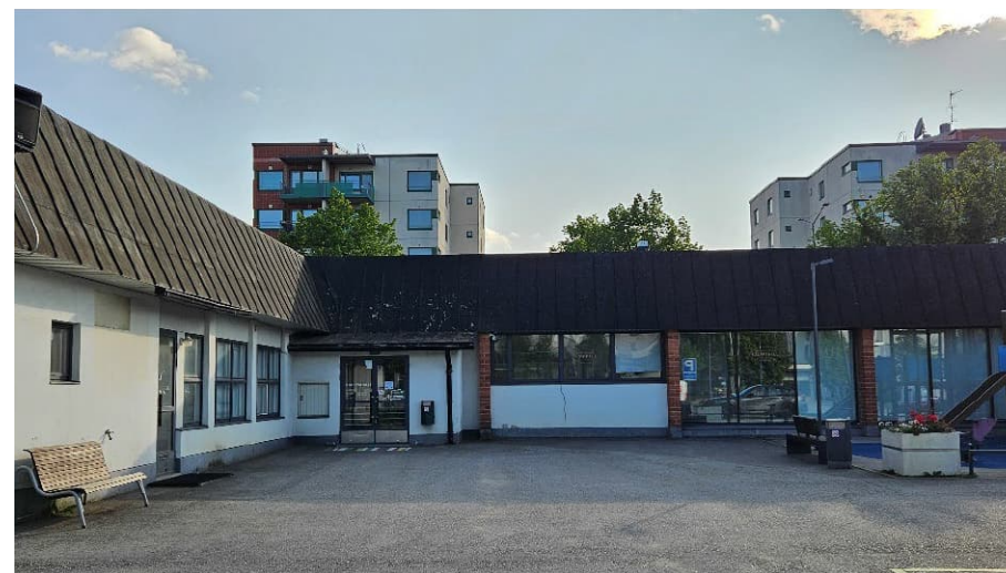
Kuva 80. Itäjulkisivua ja sisäsisäänkäynti. Suuret ikkunapinnat on tehty muutostyönä 2000-luvun alussa.
