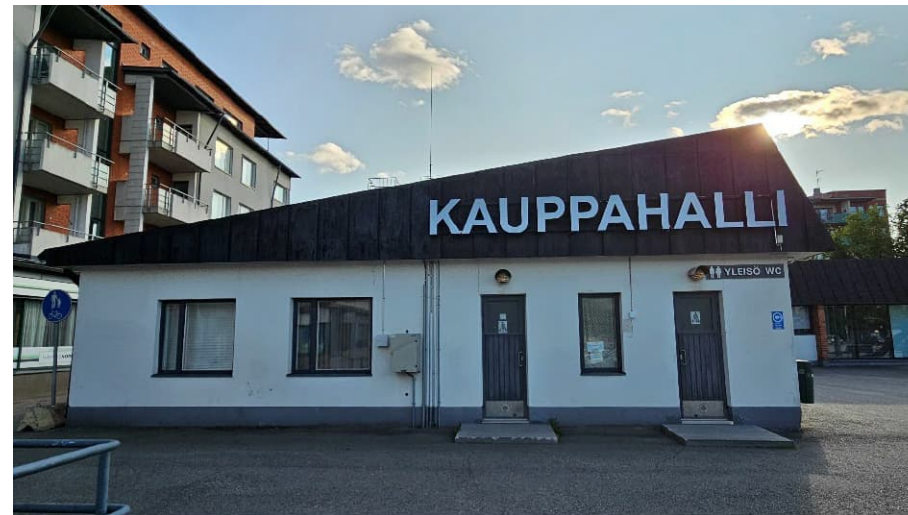
Kuva 79. Pääty itään. Vasemmalla kaksi entisen talonmiehen asunnon ikkunaa, oikealla yleisö-WC:t.
