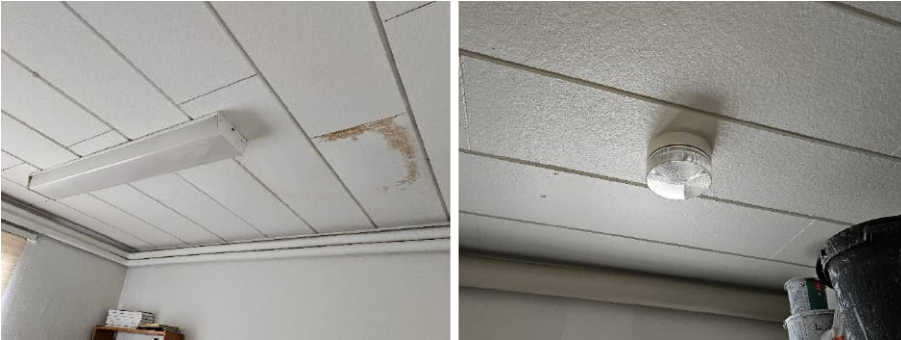
Kuva 110. Huokoista puukuitulevyä maalattuna talonmiehen asunnon ja varastojen sisäkatossa.
