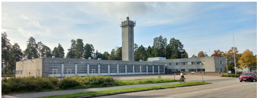
Kuva 20: Lappeenrannan paloasema katsottuna Armilankadulta. (Lappeenrannan kaupunkisuunnittelu 2023)
