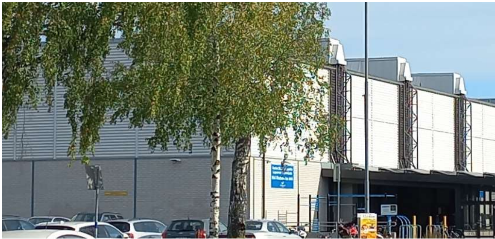
Kuva 22: Urheilutalon julkisivuja Armilankadulle, oikealla vesikaton palkkeja kannattelevat teräsristikopilarit, (Lappeenrannan kaupunkisuunnittelu 2023)
