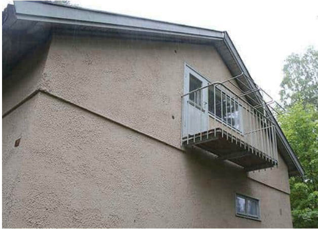
Pohjoissivun ullakkohuoneen parveke.
