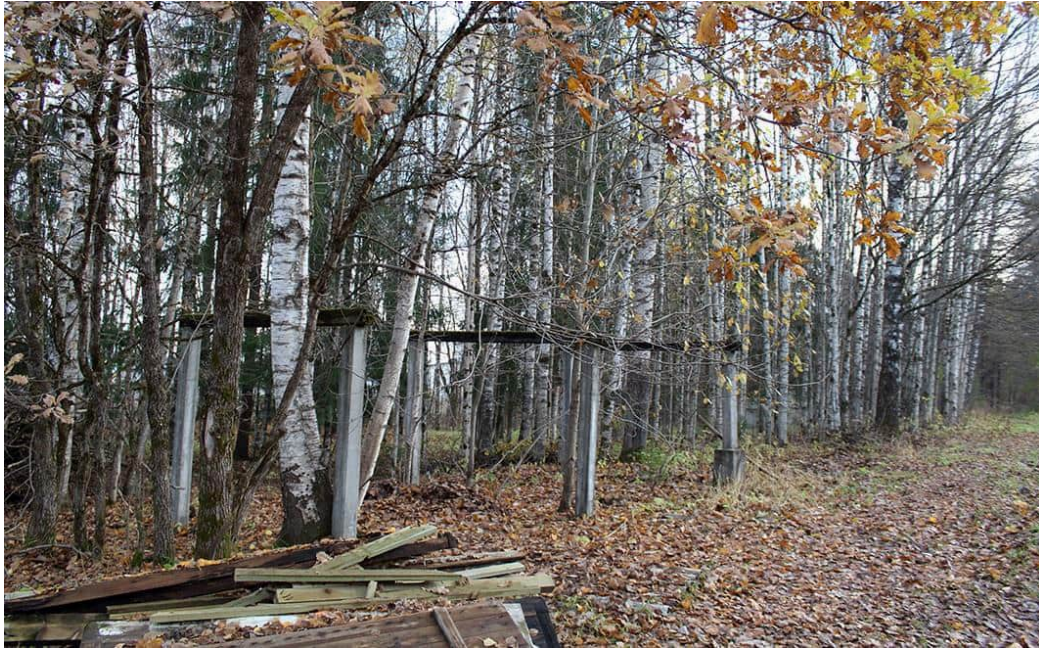
Betoni- ja puurakenteita rakennuksen itäpuoleisen rinteen tasanteella tontin rajalla.
