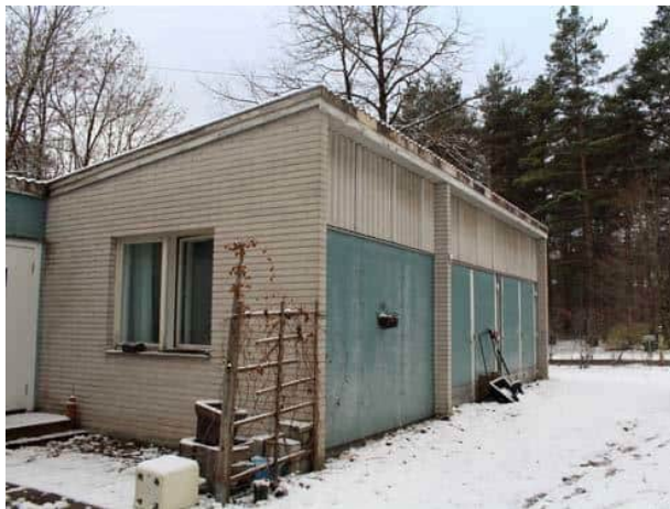
Siipiosan pohjois- ja itäjulkisivut
