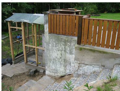
Kivi- ja betonirakenteinen varasto itäpuoleisella pihalla.
