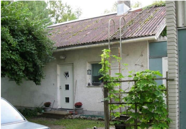
Asuinrakennuksen pohjoisjulkisivu ja ulko-ovi.
