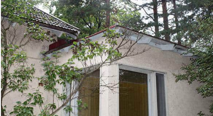
Laajennusosan katto ja ikkunat.
