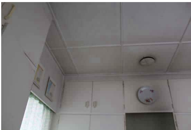
Keittiön kiinteät kaapit ja kattopaneelit.
