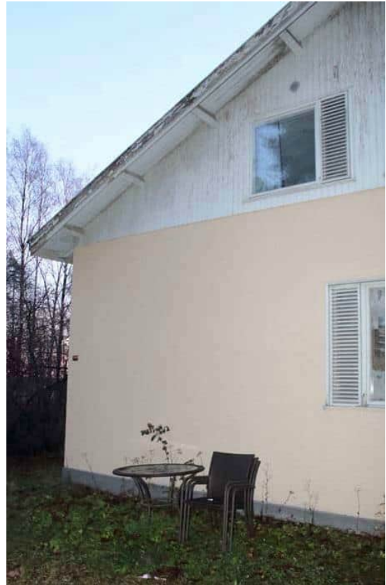
Pohjoispäädyn julkisivu ja ikkunat.
