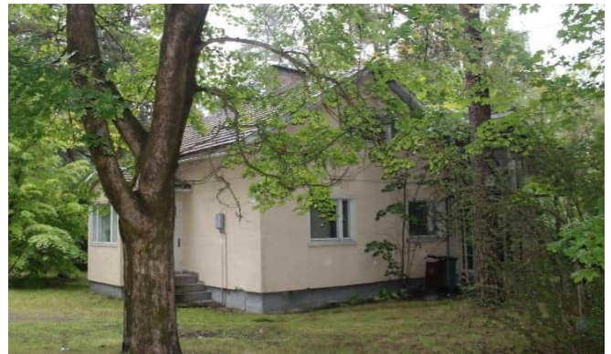
Länsi- ja eteläpäädyt
