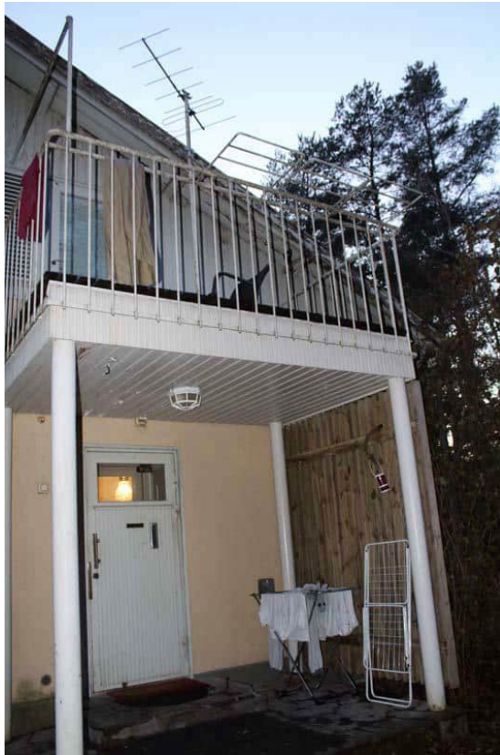
Ulko-ovi, kuisti ja 2. kerroksen parveke.
