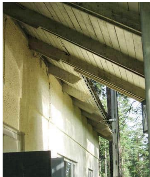
Itäsivun terassin katto
