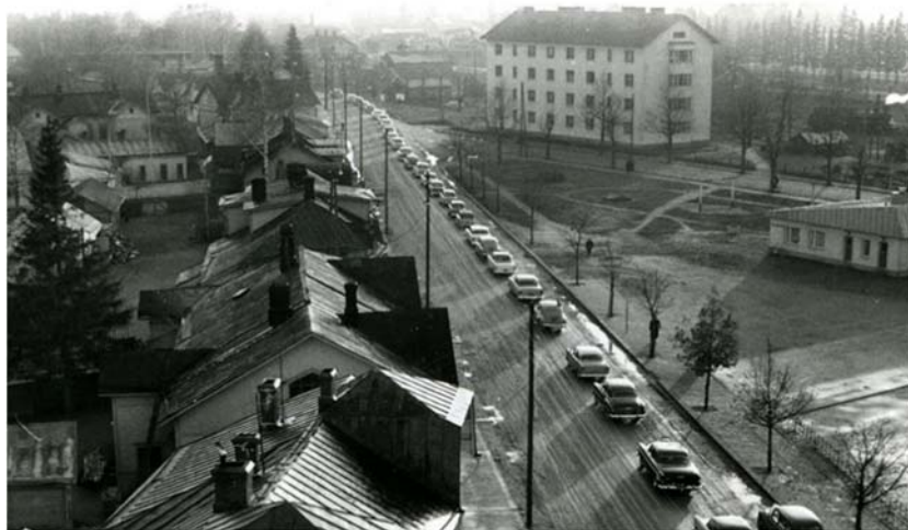
Kuva 18: Toikankadun puutaloja ja tien oikealla puolella rautatieläisten asuinkerrostalo Koljonlinna. Kuvan oikeassa reunassa on uuden kauppatorin reuna-alueita ja kauppahallin pääty. (Esko Juhola 1959, Lpr museot)
