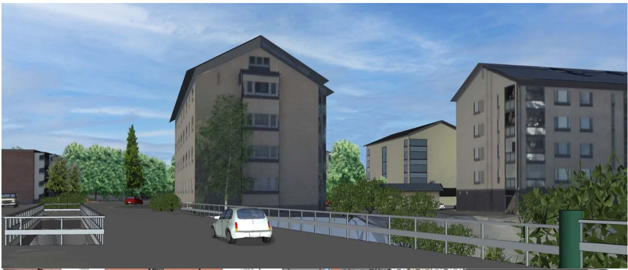
Kuva 52: Näkymä Snellmaninkadun sillalta kohti etelää, oikealla Asunto Oy Asemanpiha, seuraavana vasemmalla Keisarinaseman paikalle rakentuva uudisrakennus ja keskellä Loas Koljonlinna (Lappeenrannan kaupunkisuunnittelu) roksinen uudisrakennus ja oikealla Loas:in opiskelija-asuntola Koljonlinna. (Lappeenrannan kaupunkisuunnittelu).
