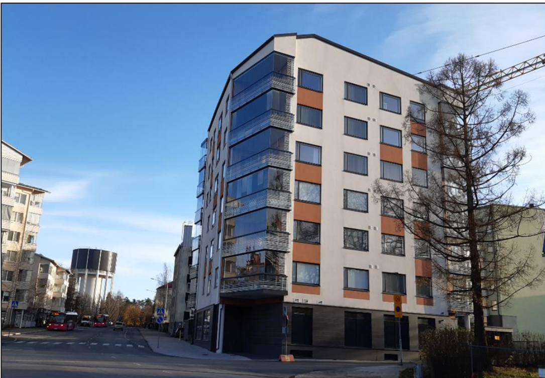
Kuva 7. As Oy Lappeenrannan Näyttämön julkisivut ovat valkoista rappauspintaa, jota on korostettu ruskeilla alueilla ikkunoiden välissä.
