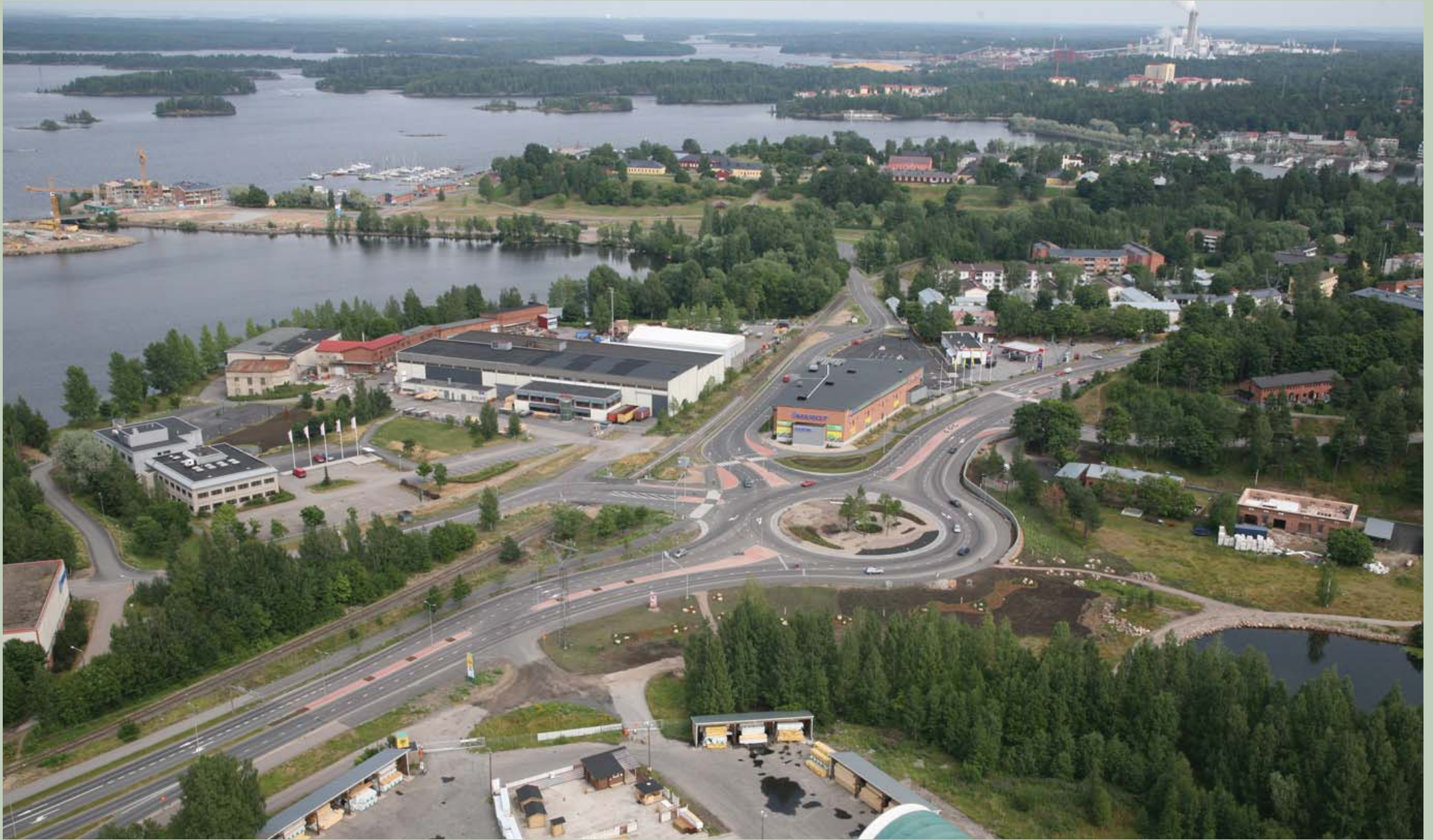
KUVA 156. Heinäkuussa 2010 otettu ilmakuva. Satamakadun, Tukkipikadun ja Taipalsaarentien ristiksessä on liikenneympyrä. Outotecin alue rajautuu teollisuusrautatiehen, Tukkipikatuun ja Satamakatuun. (Lappeenrannan kaupunki)
