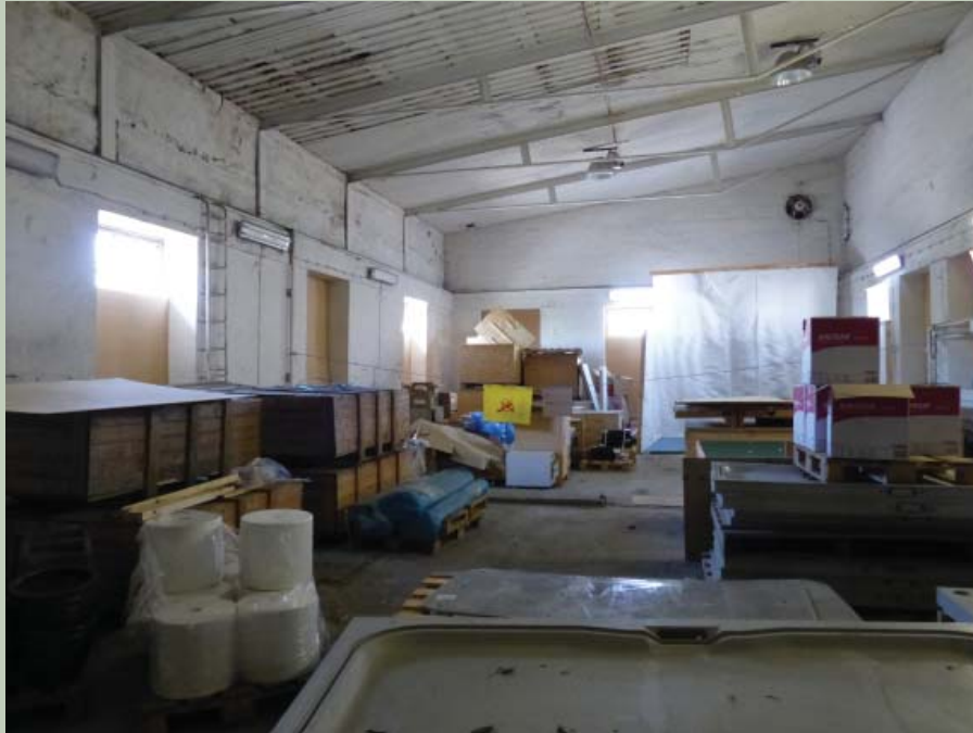
KUVA 154. Makkaratehtaan toisen kerroksen hallimainen tila. Kattotuolit ovat todennäköisesti konepajan omaa tuotantoa. Paneelikatto ja kattotuolit ovat vuoden 1942 korjauksesta.
