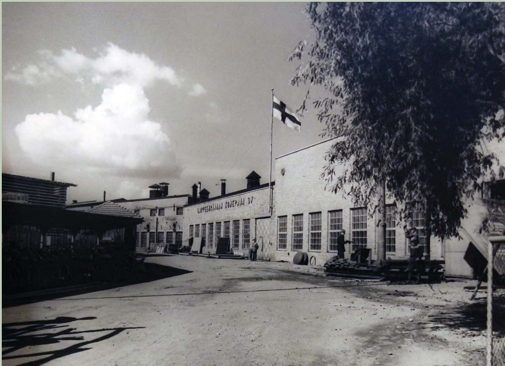
KUVA 163. Konepajan rakennukset 1960-luvulla. Vuoden 1935 laajenusosan komea puukoristeltu ovi ei ole säilynyt. (Lappeenrannan kaupunginarkisto)
